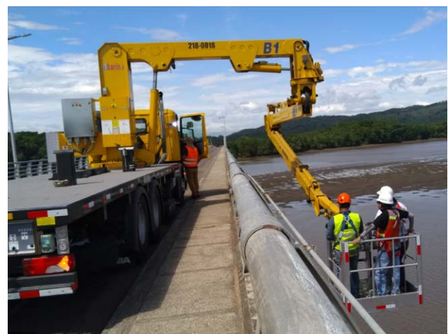
Figura 1. Ejemplos de inspecciones rutinarias de puentes en servicio de Costa Rica. (a) Puente sobre la RN105 en la RN27. (b) Puente sobre el Río Tempisque en la RN18.
