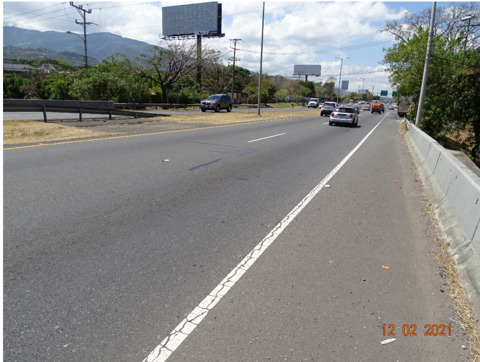
Figura 4.2. Vista a lo largo de la línea de centro (Sentido San José-Ciudad Colón).
