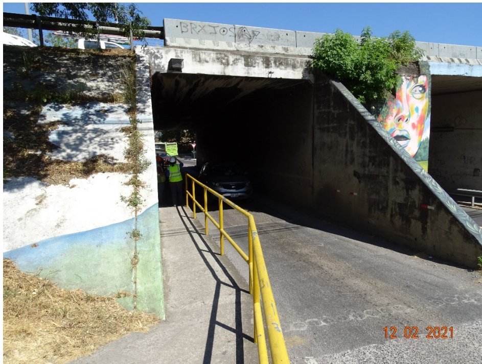
Figura 4.3. Vista lateral (costado norte)
