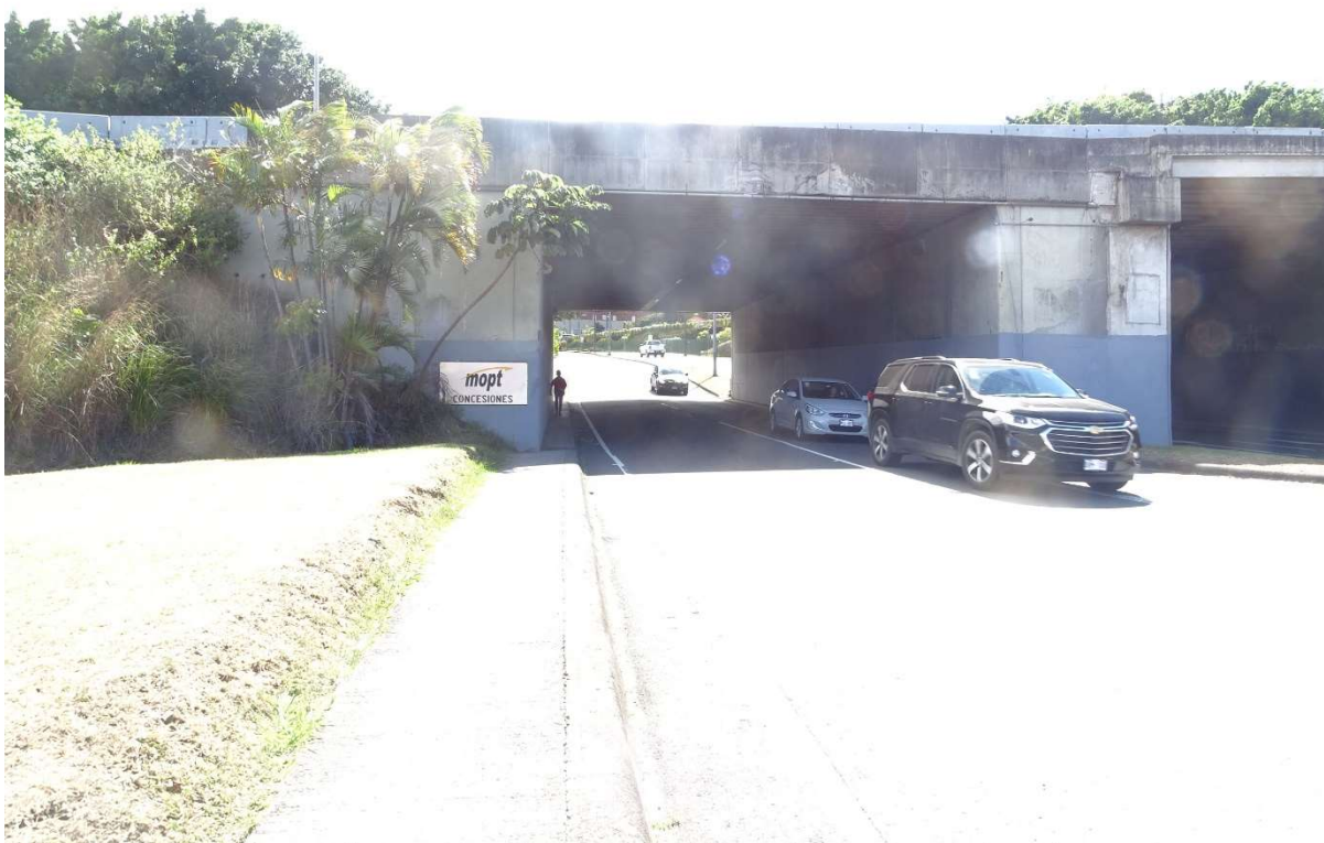
Figura 4.3. Vista lateral (costado norte)
