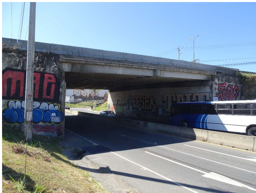
Figura 4.3. Vista lateral (costado norte)
