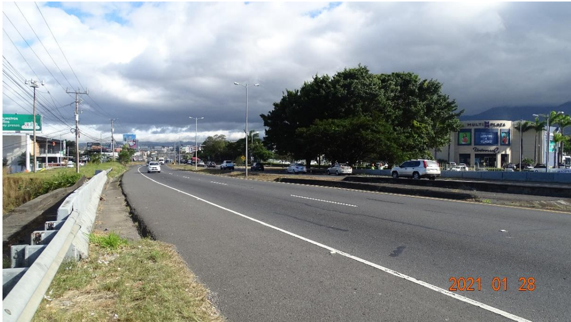
Figura 4.2. Vista a lo largo de la línea de centro (hacia San José).
