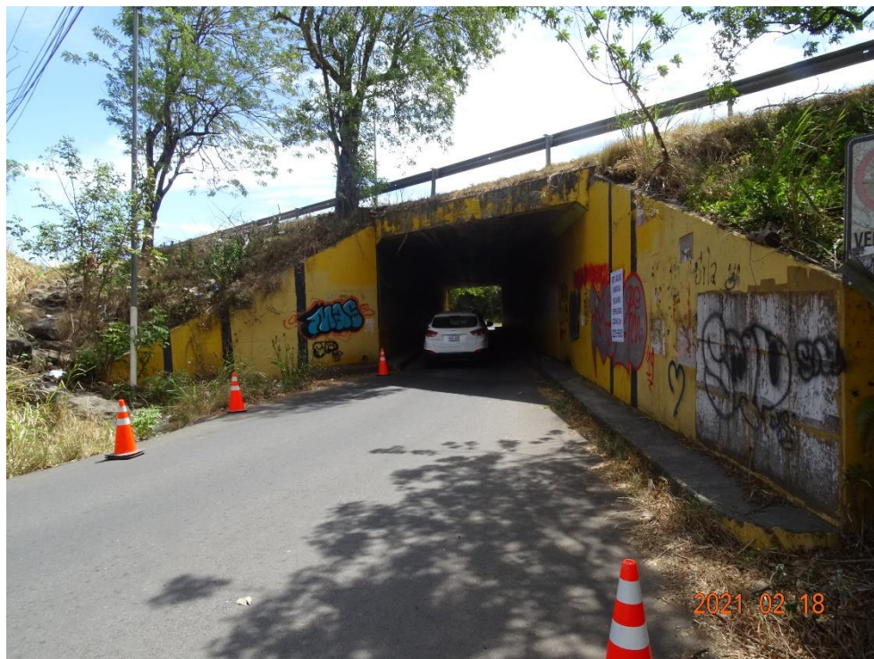
Figura 4.3. Vista lateral (costado norte)
