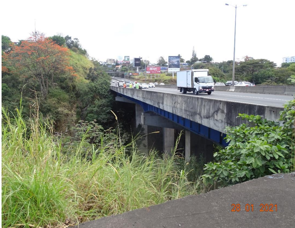
Figura 4.3. Vista lateral (costado aguas abajo)
