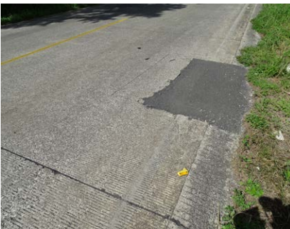
Figura 61. Bacheo permanente con pavimento asfáltico Fuente: LanammeUCR. (2020)
