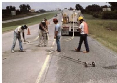
Figura 46. Inyección de lechada de concreto para el levantamiento localizado de losas
