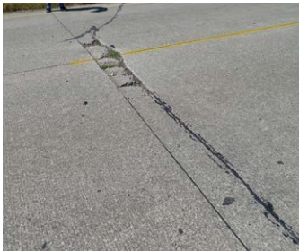
Figura 13. Grietas por punzonamiento (punchout)
