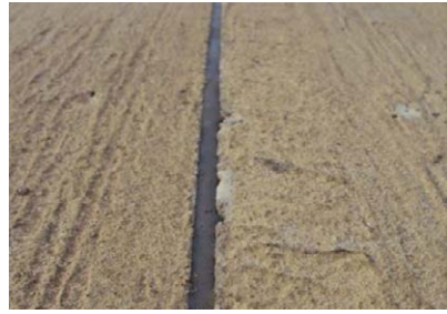
Figura 30. Sellado de juntas Fuente: Calo. (2018)
