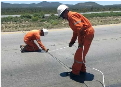
Figura 29. Colocación del cordón de respaldo y el material sellante
