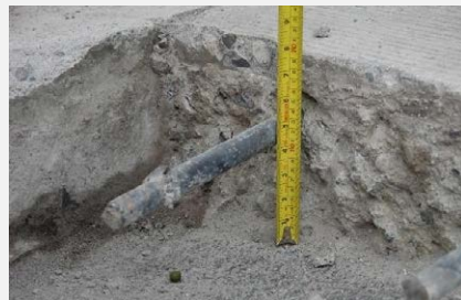
Figura 60. Dovelas no colocadas a la mitad de la losa Fuente: LanammeUCR. (2009)
