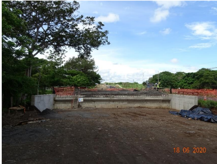
Figura 16. Avance en la construcción del puente sobre el Río Salitral. Colado y curado del tablero de la losa del puente nuevo aguas arriba.
