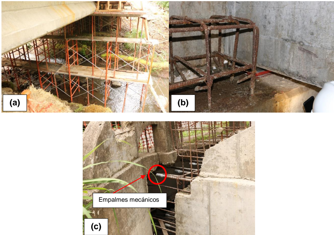
Figura 5. Observaciones realizadas en la subestructura del puente sobre Río Desjarretado. (a) Talud conformado frente al bastión 1 (hacia Limonal). (b) Acero de refuerzo de llave cortante en viga cabezal de bastión 2 (hacia Cañas). (c) Junta de construcción vertical y empalmes mecánicos del refuerzo longitudinal en bastión 2 (hacia Cañas).
