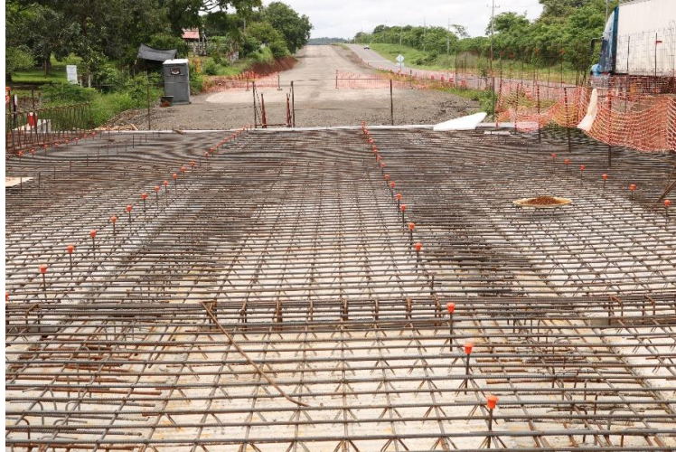
Figura 13. Avance en la construcción del puente sobre el Río San Miguel. Proceso de encofrado y colocación del acero de refuerzo de la losa para vaciar.
