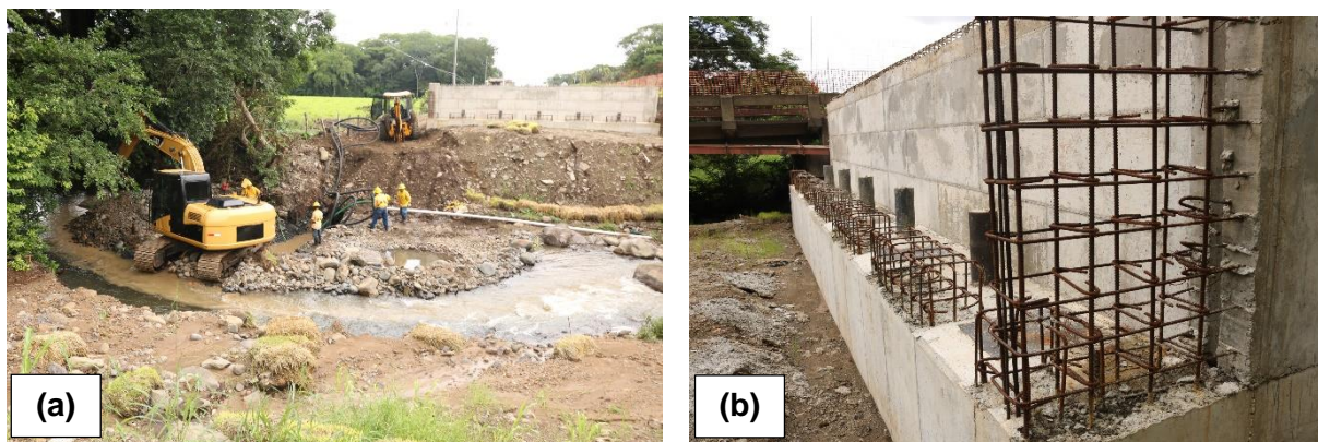
Figura 7. Avance en la construcción del puente sobre el Río Lajas. (a) Trabajos de reubicación de servicios por la institución encargada del mismo. (b) Bastión 2 (hacia Cañas) completado hasta nivel de viga cabezal y parapeto.
