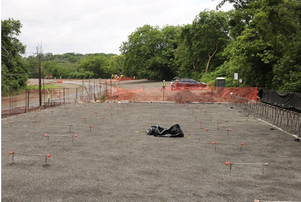
Figura 3. Avance en la construcción del puente sobre el Río Desjarretado. Proceso de curado de la losa del tablero en la sección aguas abajo de la estructura.
