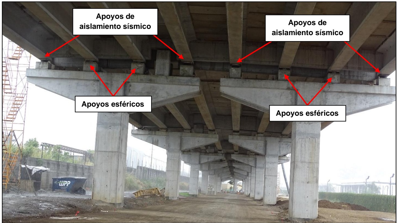
Figura 13. Tipos de apoyo que se utilizan en las pilas del viaducto.
