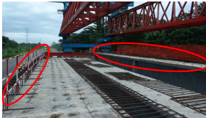
Figura 13. Vigas del puente sobre la Quebrada Calderón. Se pueden observar arranques para la barrera vehicular sobre las vigas a ambos lados del puente.
