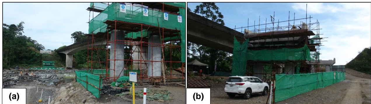
Figura 3. Avance en la construcción del puente sobre el Río Toro Amarillo. (a) Pilas 1 y 4 en construcción, al fondo el Bastión 1 construido. (b) Pila 5 en construcción, al fondo la Pila 6 construida.
