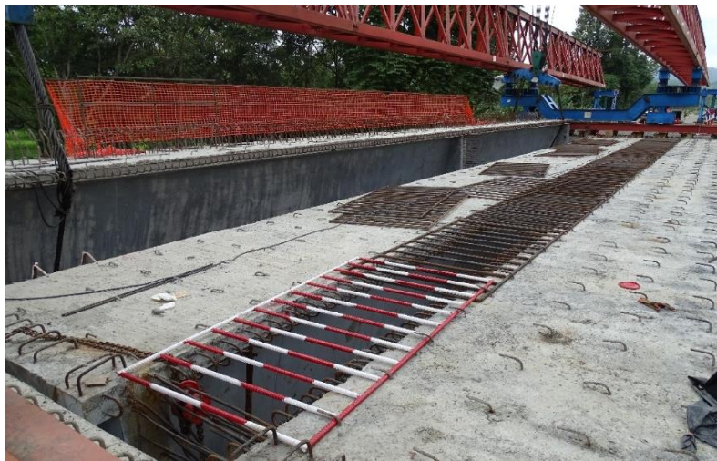
Figura 12. Avance en la construcción del puente sobre la Quebrada Calderón. Se estaba trabajando en la colocación de las vigas de la superestructura.
