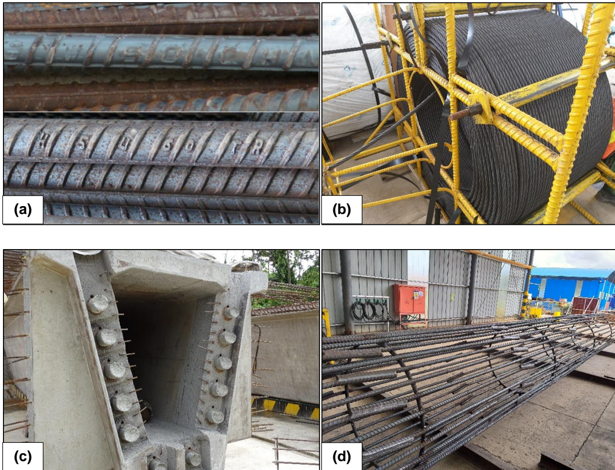
Figura 18. Observaciones realizadas en el plantel de prefabricado de Guápiles. (a) Procedencia del acero de refuerzo utilizado en el proyecto. (b) Torones de acero utilizados para el preesfuerzo de las vigas cajón. (c) Extremo de una viga cajón, se puede observar el relleno de los ductos de postensión. (d) Traslapes soldados utilizados en el refuerzo longitudinal de los pilotes.
