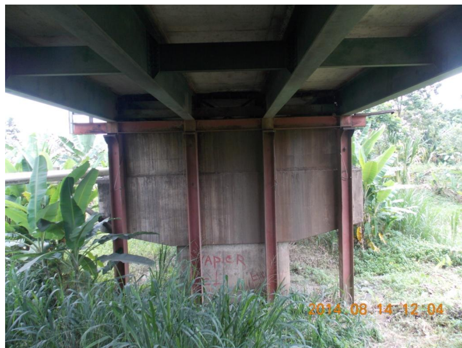
Figura 24. Sistema de soporte colocado al costado de la pila 7 para evitar el colapso de la superestructura 2.
