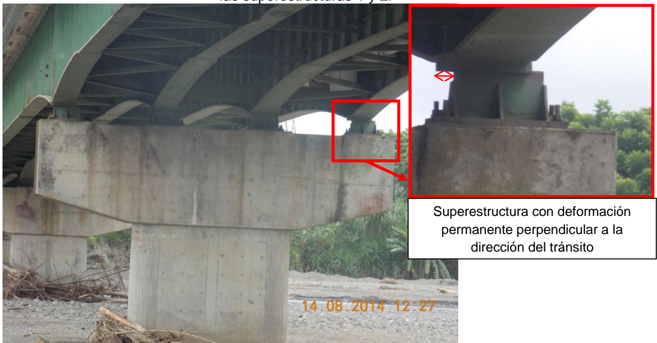
Figura 16: Vista de pila 3 desde el acceso este.
