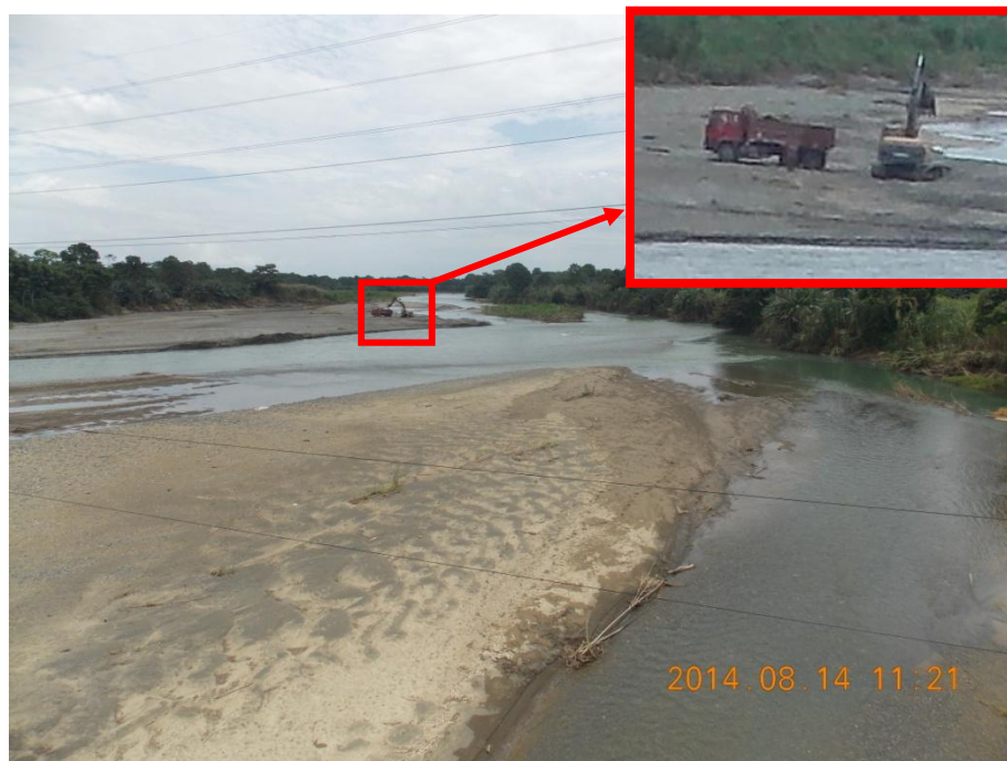
Figura 10: Extracción de material aguas abajo del puente.
