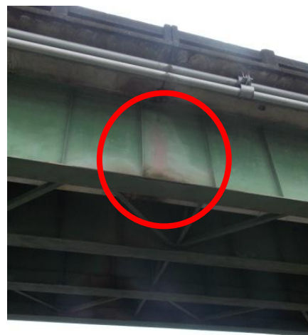
Figura 14: Corrosión localizada en vigas principales de la superestructura 2 debido al ingreso de agua a través de las juntas de losa.
