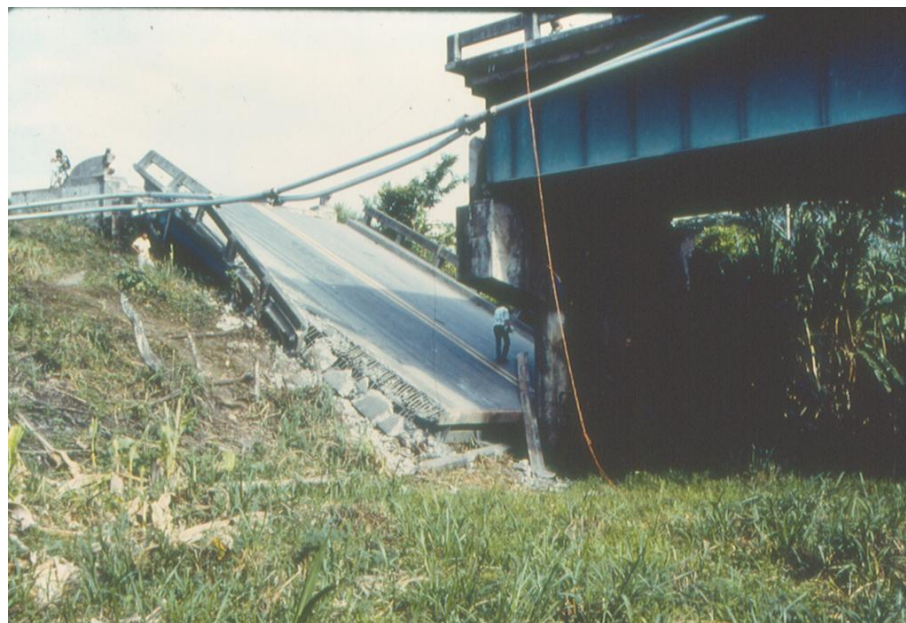
Figura 8: Superestructura-este colapsada debido terremoto de Limón de 1991. Se colocó un relleno sobre la superestructura colapsada. (Fuente: Laboratorio de Ingeniería Sísmica)
