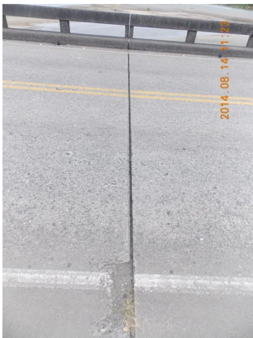
(a) Vista general de la junta de losa
