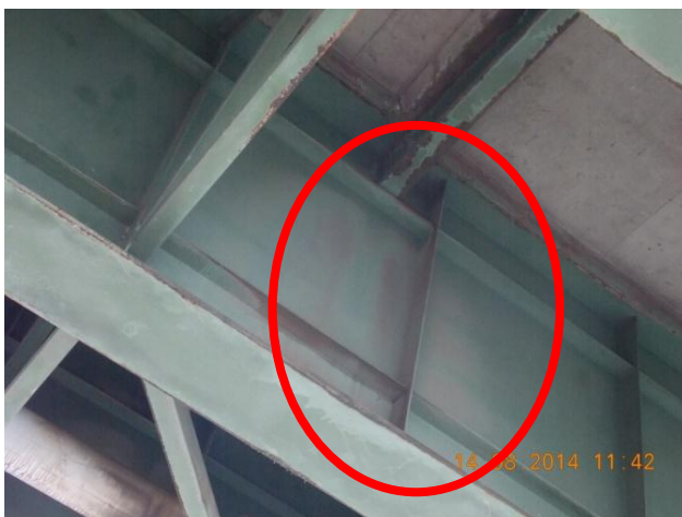
Figura 14: Corrosión localizada en vigas principales de la superestructura 2 debido al ingreso de agua a través de las juntas de losa.
