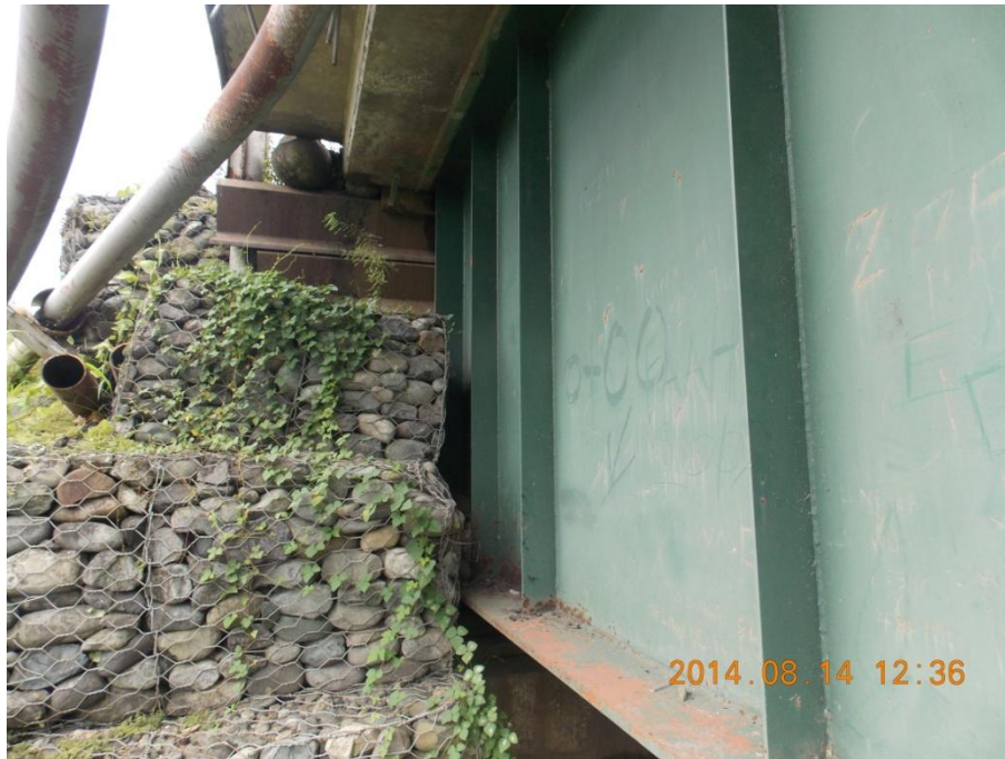
Figura 9: Muro de gaviones para retención del relleno-este en contacto directo con viga principal de acero de la superestructura 1.
