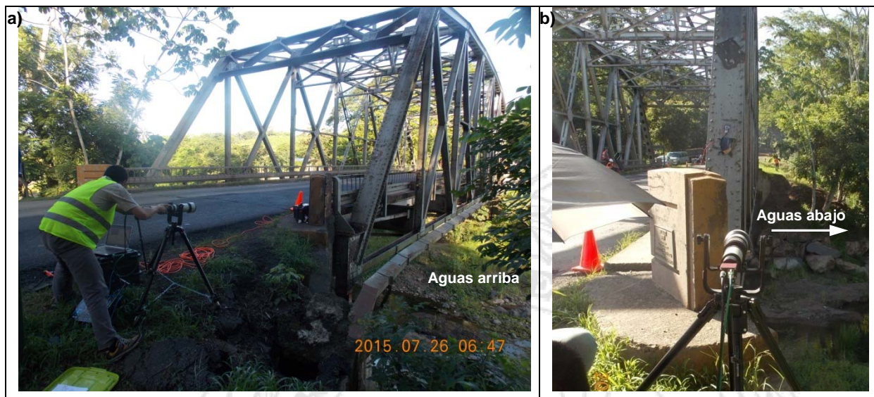
Figura 92. a) Ubicación de la cámara para la medición de nodos costado aguas arriba, b) medición de nodos costados aguas abajo.
