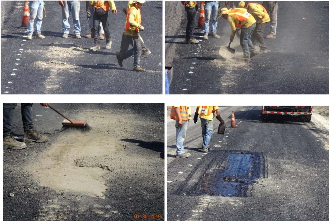
Figura 14. Reparación en zonas de material suelto observadas en paños mejorados con cemento. Ruta Nacional 160, Tambor - Cóbano. Sección de Control 60813, Estacionamiento: 3+900 desde Tambor. Fecha: 31 ene 2019. Fuente: Unidad de Auditoría Técnica, LanammeUCR
