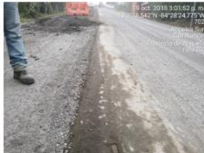
Foto No.1 Primer carril estabilizado con traslape.
