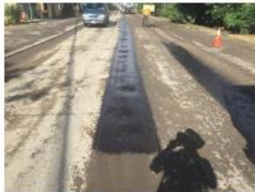
Foto No.3. preparación de la superficie.
