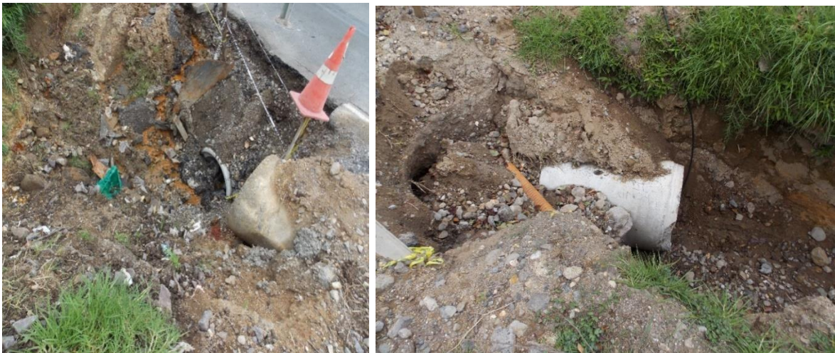
Figura 20. Condición lateral de la tubería colocada. Ubicación: Ruta Nacional 2, 6+800 del cruce de La Sierra (km 52+550). Sección de control 10042, La Sierra (R.222) – El Empalme (R.226). Fecha: 30 de abril de 2019. Fuente: Nota informe LM-IC-D-0311-19. Unidad de Auditoría Técnica, LanammeUCR.
