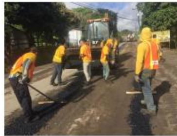
Foto No.4. Colocación de mezcla asfáltica como prenivelación.
