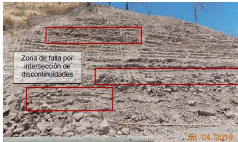
Figura 5. Talud al lado derecho de la estación 13+397
