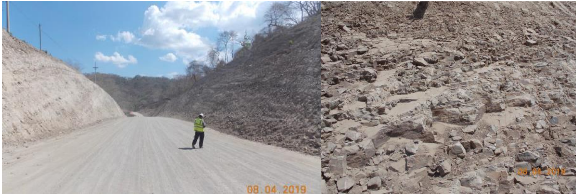
Figura 4. Taludes a ambos lados de la carretera de la estación 4+260.
