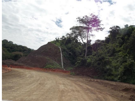
Figura 17. Contracuneta instalada en el estacionamiento 7+783 con pendiente considerable. Fecha de la fotografía: 27/06/2019. Fuente: LanammeUCR,2019
