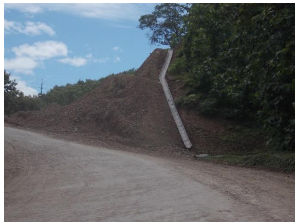
Figura 19. Contracuneta instalada en el estacionamiento 13+506 con pendiente considerable. Fecha de la fotografía: 27/06/2019. Fuente: LanammeUCR,2019
