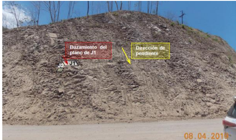
Figura 6. Talud al lado derecho de la estación 17+360
