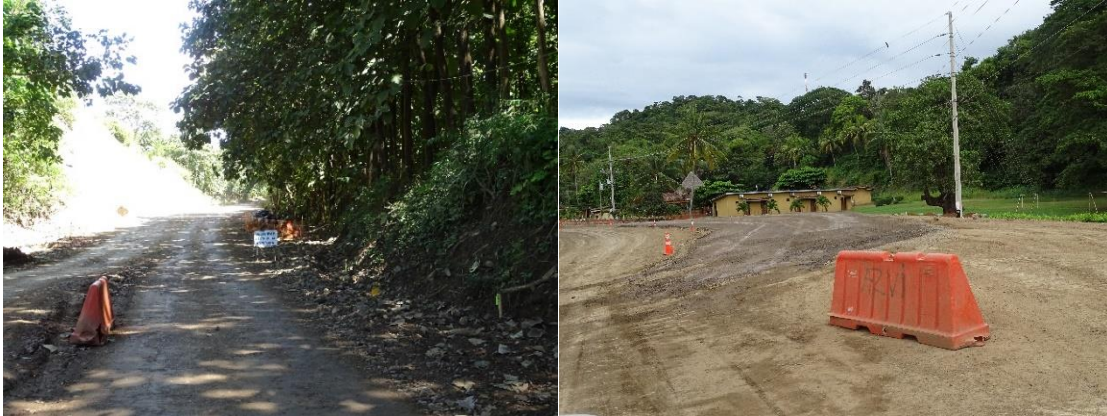
Figura 39. Barrera sueltas, en mal estado y sin retroreflectivo.
