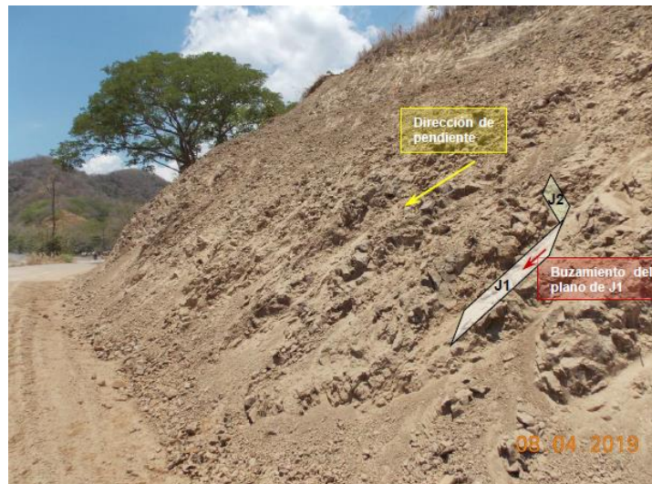
Figura 7. Talud al lado derecho de la estación 19+440
