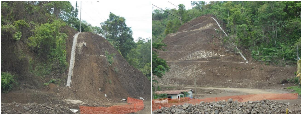
Figura 18. Contracunetas instaladas en el estacionamiento 8+465 con pendientes considerables. Fecha de la fotografía: 22/05/2019. Fuente: LanammeUCR,2019
