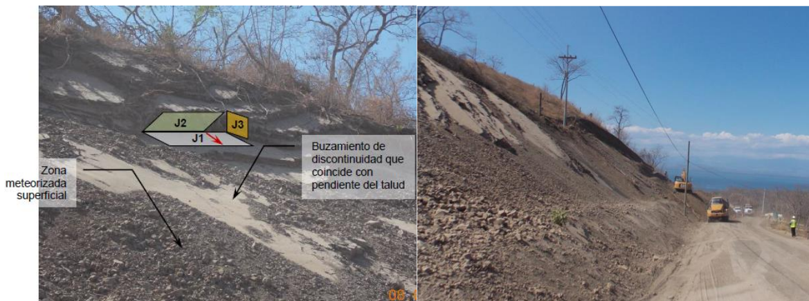
Figura 3. Talud al lado derecho de la estación 3+286.
