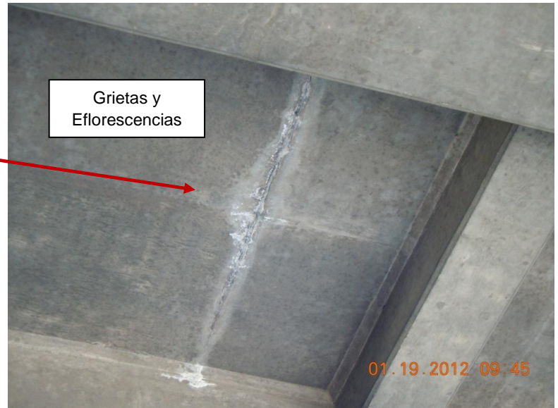
Figura 19: Grietas transversales en la superficie inferior de la losa y eflorescencia
