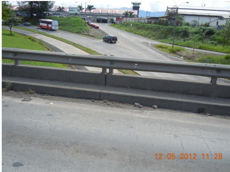
Figura 4: Baranda compuesta (concreto-acero) con elementos tipo “flex-beam”.
