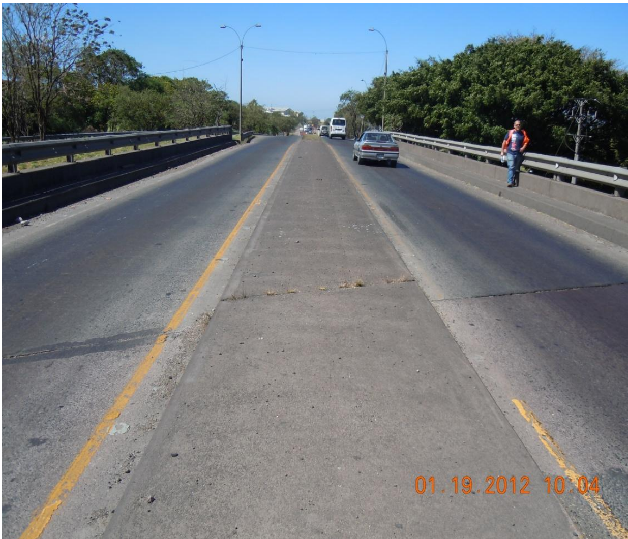
Figura 2: Vista a lo largo de la línea de centro del paso inferior Aeropuerto
