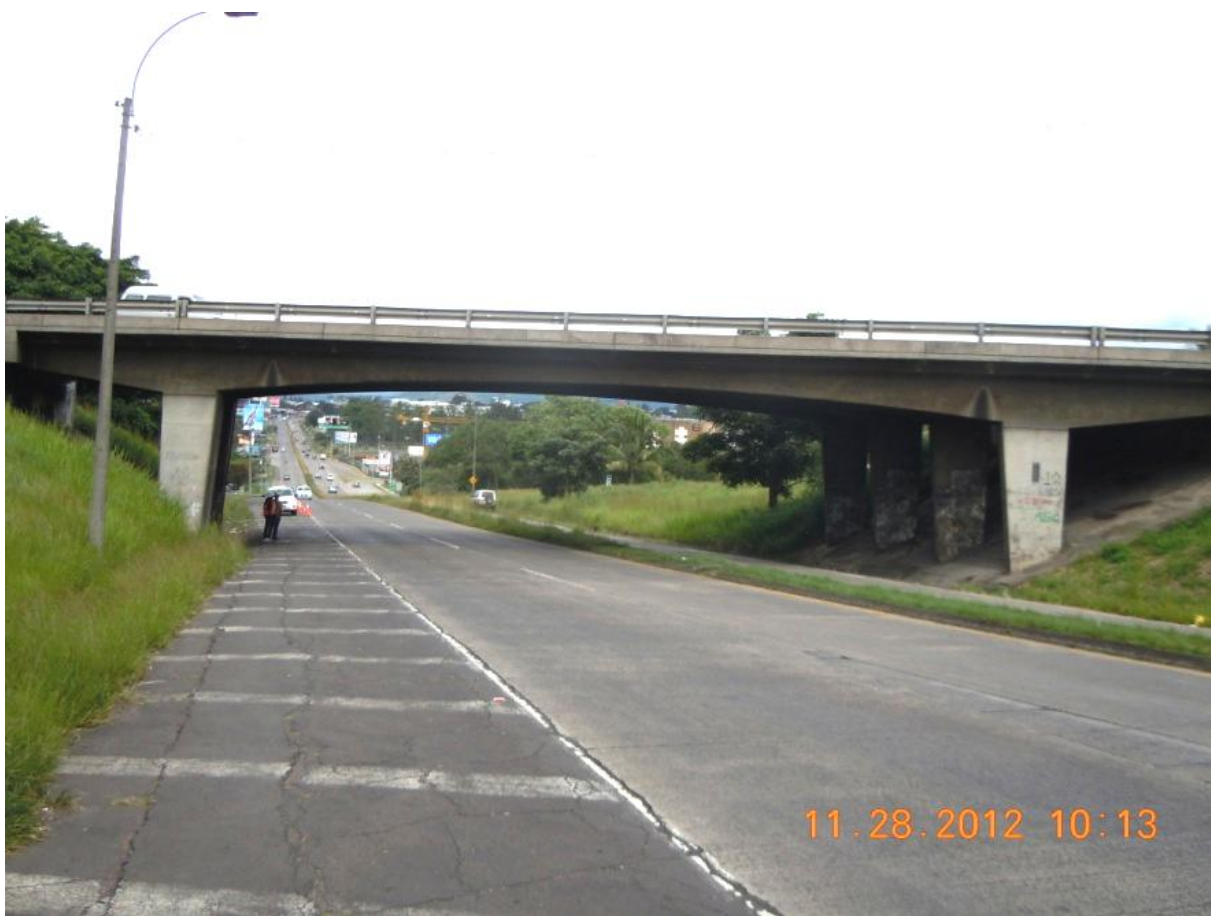
Figura 3: Vista lateral del paso inferior Aeropuerto (Lado Sur)
