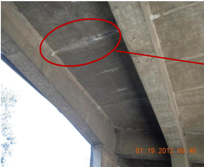
Figura 19: Grietas transversales en la superficie inferior de la losa y eflorescencia
