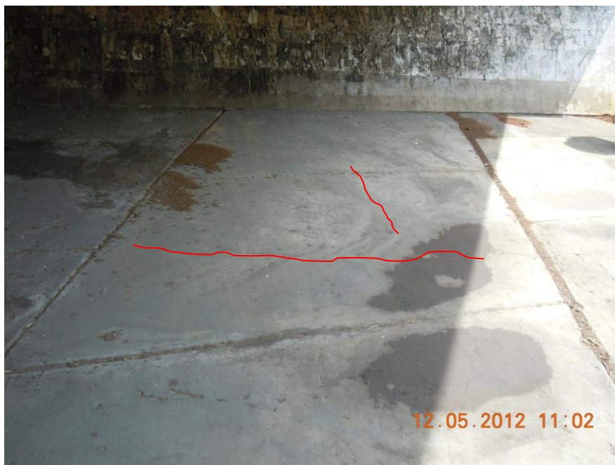
Figura 24: Grietas en la protección del talud del acceso este
