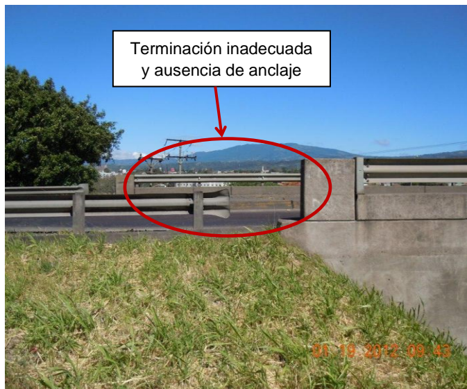
Figura 7: Los guardavías no están anclados a la baranda del paso a desnivel y cuenta con terminaciones inadecuadas
