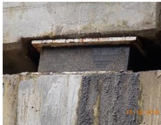
Figura 59. Condición de apoyo en bastión de puente Quebrada San Pedro(E1). Fecha de la fotografía 18 de octubre 2018.Fuente: LanammeUCR.
