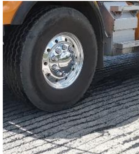
Figura 49. Riego de liga aplicado sobre la capa de base estabilizada. Estación 42+150. Fecha: 16-02-2018. Fuente: LanammeUCR.
