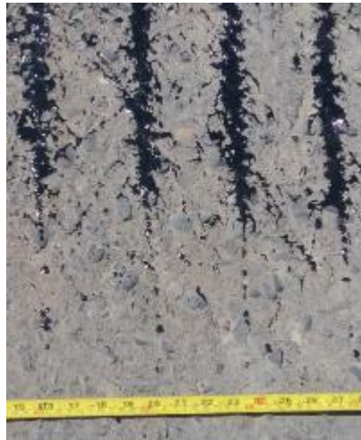
Figura 49. Riego de liga aplicado sobre la capa de base estabilizada. Estación 42+150. Fecha: 16-02-2018. Fuente: LanammeUCR.
