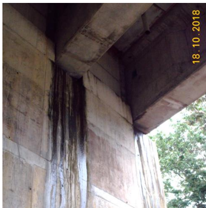
Figura 59. Condición de apoyo en bastión de puente Quebrada San Pedro(E1). Fecha de la fotografía 18 de octubre 2018.Fuente: LanammeUCR.
