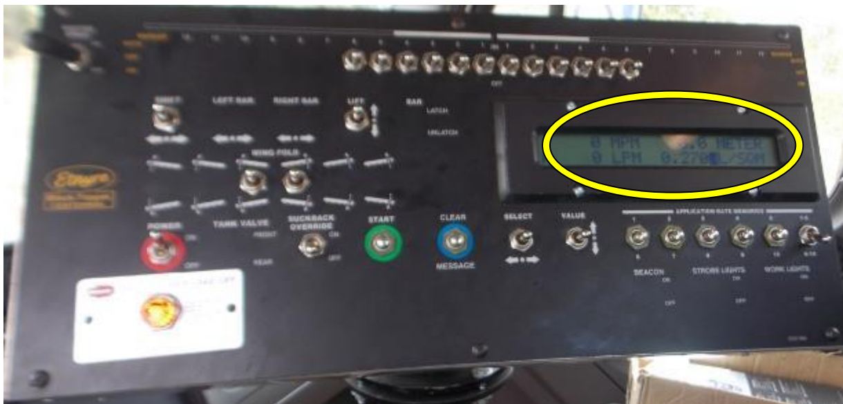
Figura 50. Panel de control del camión distribuidor de asfalto. Estación 42+150. Fecha: 16-02-2018. Fuente: LanammeUCR.
