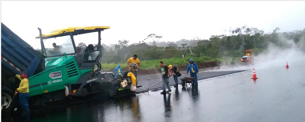
Figura 46. Colocación de mezcla asfáltica en condición lluviosa. Estacionamiento 40+600. Fecha de la fotografía 29-jun-2018. Fuente: LanammeUCR.
