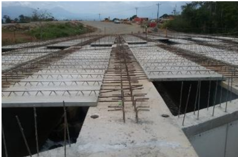
Figura 56. Prelosas del puente E-2.
