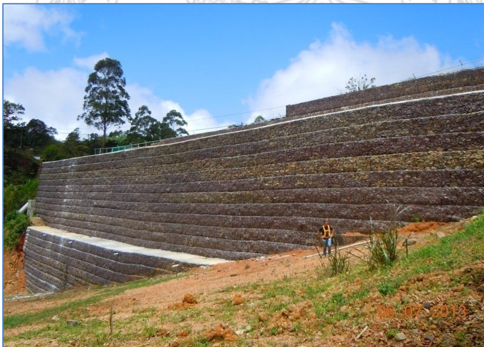
Fotografía N°1. Vista frontal del muro de contención.
