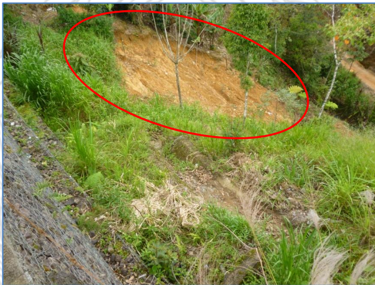
Fotografía No. 14. Deslizamiento reciente en el talud al lado opuesto de la carretera.
