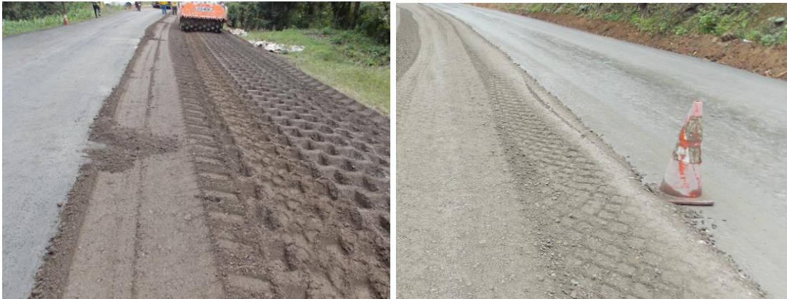
Figura 10. Ejemplo de rehabilitación donde se garantiza una junta efectiva entre paños estabilizados. Ruta Nacional 2, tramo entre cruce de La Sierra y cruce del Empalme. Estacionamiento: 3+500 y 1+800 respectivamente del cruce de La Sierra (R.222). Fecha: 30 abr 2019. Fuente: Unidad de Auditoría Técnica, LanammeUCR
