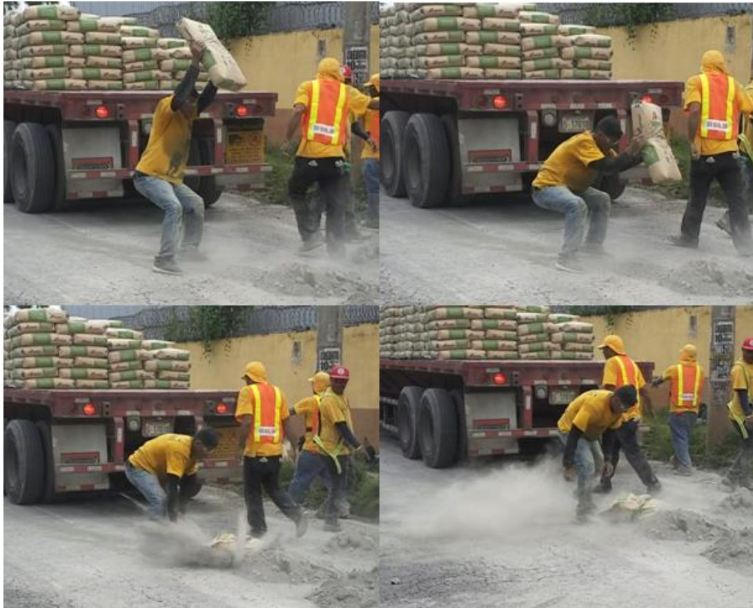
Figura 7. Ejemplo de frente de obra donde se aplica el lanzamiento de sacos de cemento sobre la superficie que sería estabilizada. Ubicación: Ruta Nacional 17, sección de control 60622 (Chacarita [plantel MOPT] – El Cocal [escuela]), km 7+630 desde el cruce con la Ruta Nacional 23. Fecha: 13 de junio de 2018. Fuente: LM-PI-051-2018. Unidad de Auditoría Técnica, LanammeUCR.
