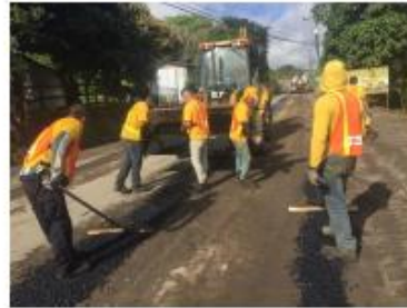
Foto No.4. Colocación de mezcla asfáltica como prenivelación.
