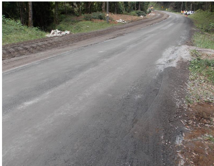
Figura 16. Material de secado se conserva en la vía hasta la colocación de la capa asfáltica. Ruta Nacional 2, tramo entre cruce de La Sierra y cruce del Empalme. Estacionamiento: 3+200 del cruce de La Sierra (R.222). Fecha: 30 abr 2019. Fuente: Unidad de Auditoría Técnica, LanammeUCR
