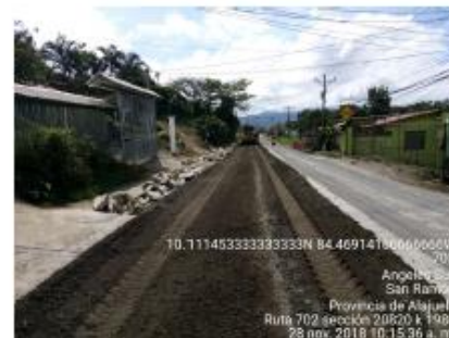
Foto No.2. Carril en proceso hasta el centro de la vía.
