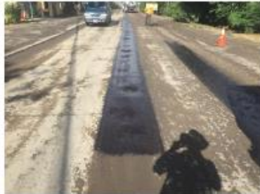
Foto No.3. preparación de la superficie.
