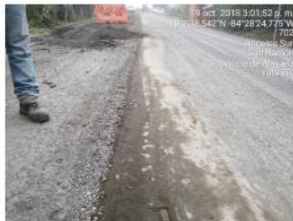
Foto No.1 Primer carril estabilizado con traslape.
