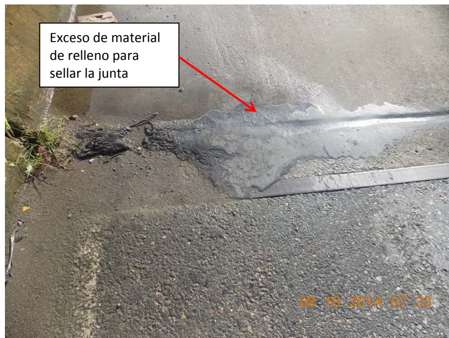
Figura 6: Detalle de la junta de expansión.
