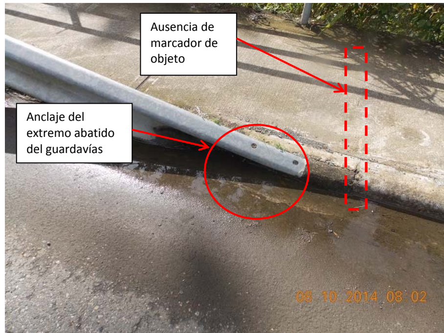
Figura 3: Detalle del extremo abatido del guardavías y ausencia de marcador de objeto.
