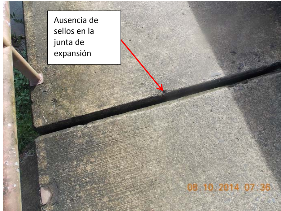
Figura 7: Junta de expansión de las aceras.
