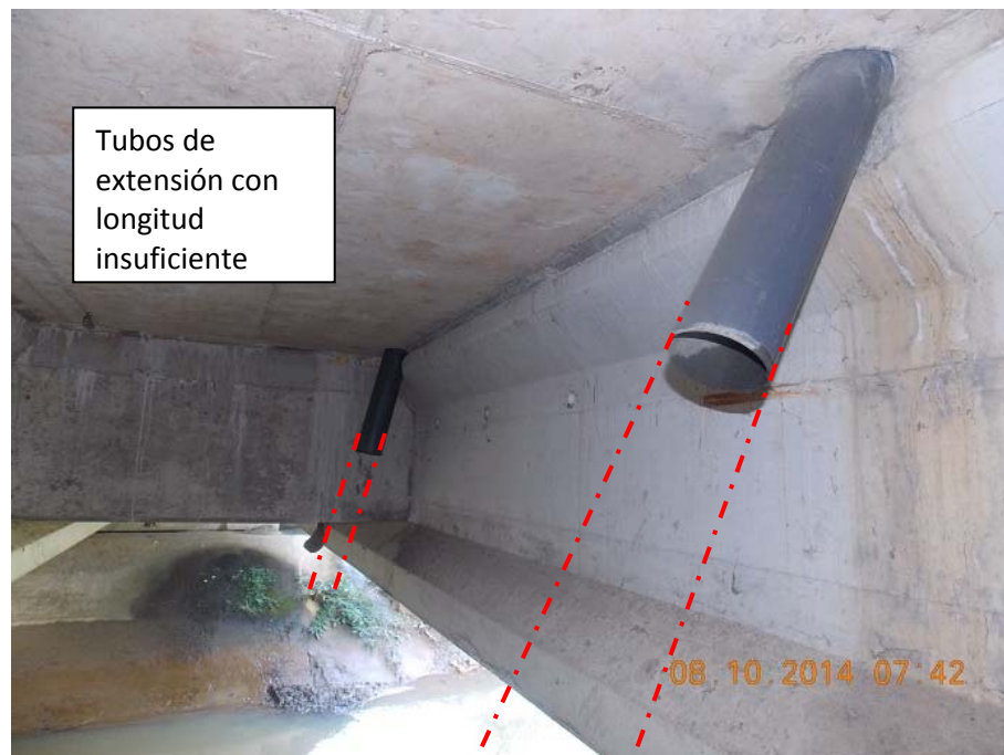
Figura 5: Detalle de los tubos de extensión de los drenajes.
