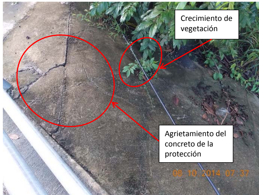
Figura 9: Revestimiento de los taludes laterales de los accesos.
