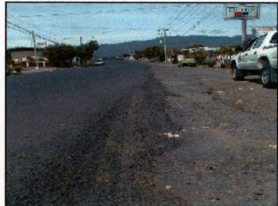
Fotografía 4: Vista general de acabado de borde.
