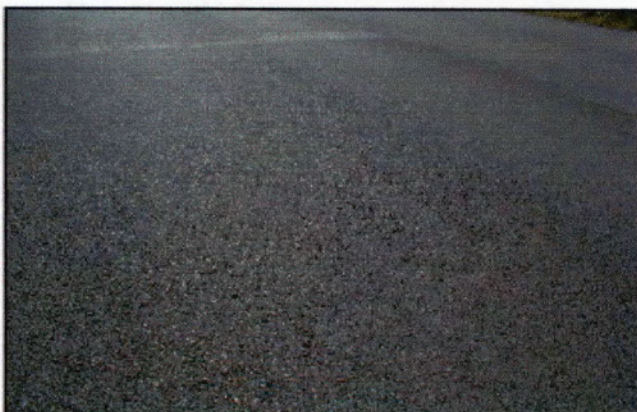
Fotografía 3: Detalle de acabado superficial de sobre – capa.
