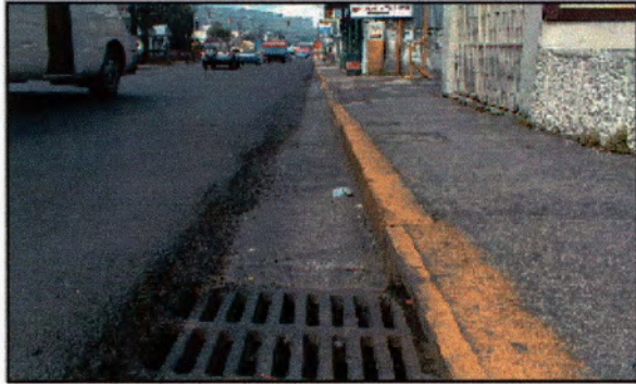
Fotografía 4: Detalle de un correcto acabado de borde de sobrecapa.
