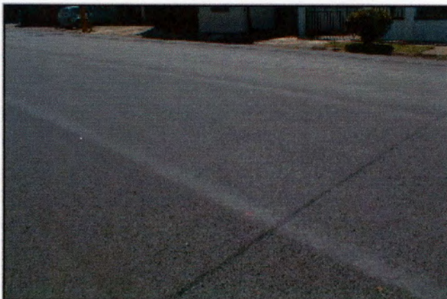
Fotografía 5: Detalle de acabado de junta de sobrecapas y acabado de superficie.
