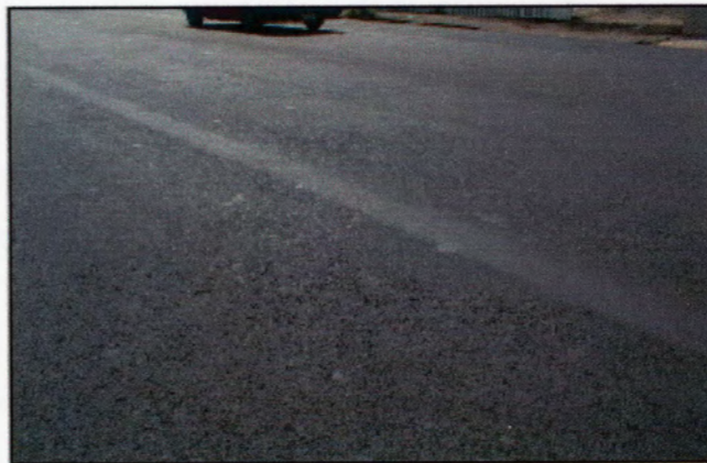
Fotografía 2: Detalle de junta y acabado superficial de sobrecapa.
