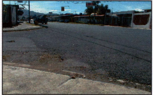
Fotografía 7: Acabado final de boca – calle.
