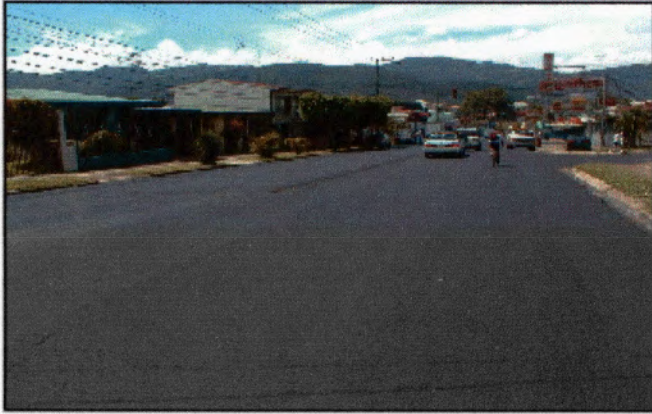
Fotografía 4: Avance del recarpeteo a 300 m de la iglesia de San Francisco.
