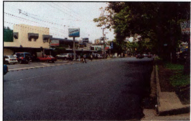
Fotografía 4: Vista general de recarpeteo y acabado de borde.
