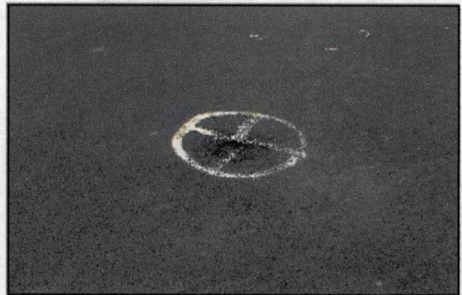
Fotografía 1: Identificación de áreas para levantamiento de tapas de alcantarillado.
