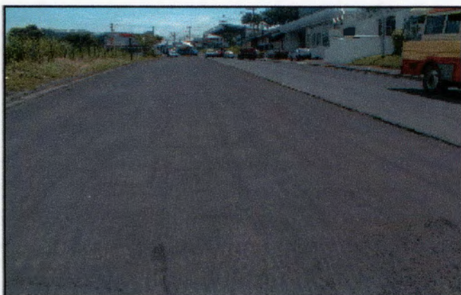
Fotografía 1: Saneamiento previo de antigua carpeta, vía escarificado.
