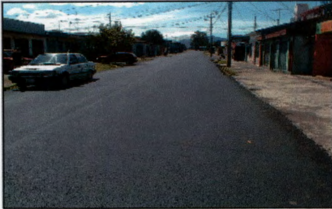
Fotografía 1: Vista general de trabajos de recarpeteo.
