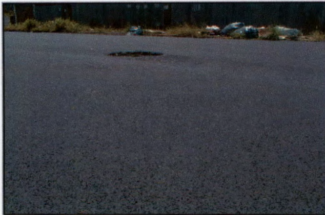
Fotografía 4: Detalle de acabado superficial de sobre – capa.
