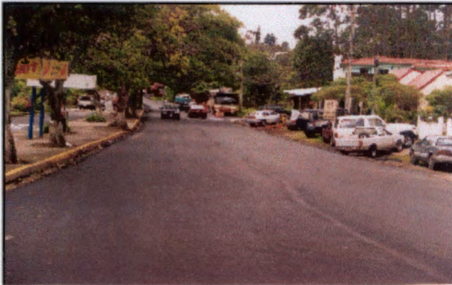
Fotografía 1: Vista general de recarpeteo en las inmediaciones de la U.C.R.
