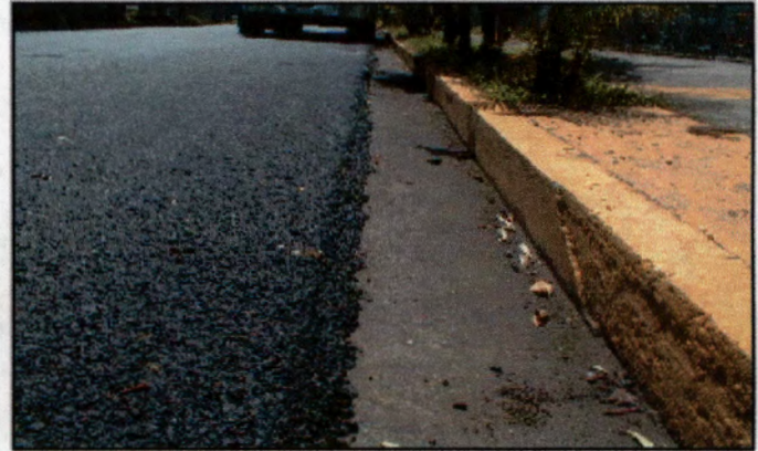
Fotografía 4: Detalle de un adecuado acabado de borde de sobe – capa.
