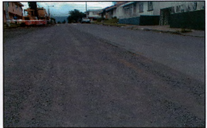
Fotografía 1: Trabajos de escarificación en calle 16.
