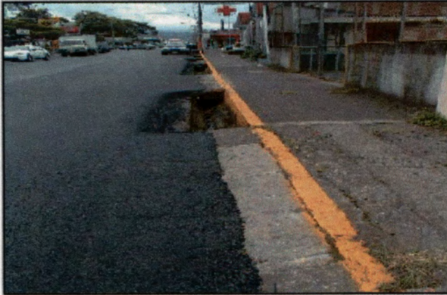
Fotografía 4: Vista general de acabado de borde y accesos de sobre – capa.
