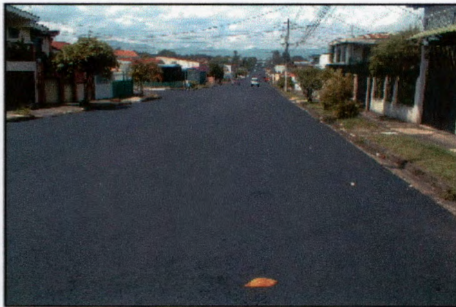
Fotografía 2: Vista general de trabajos de recarpeteo de calle 16 de Tibas.
