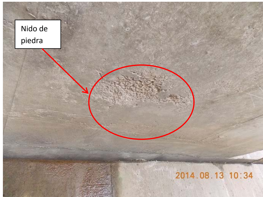
Figura 12: Nido de piedra en la cara inferior del cajón junto al bastión oeste.
