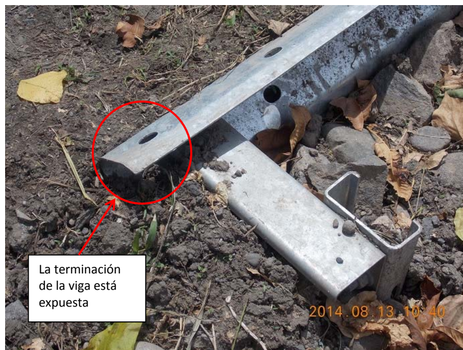
Figura 3: Detalle de conexión de guardavías al terreno.
