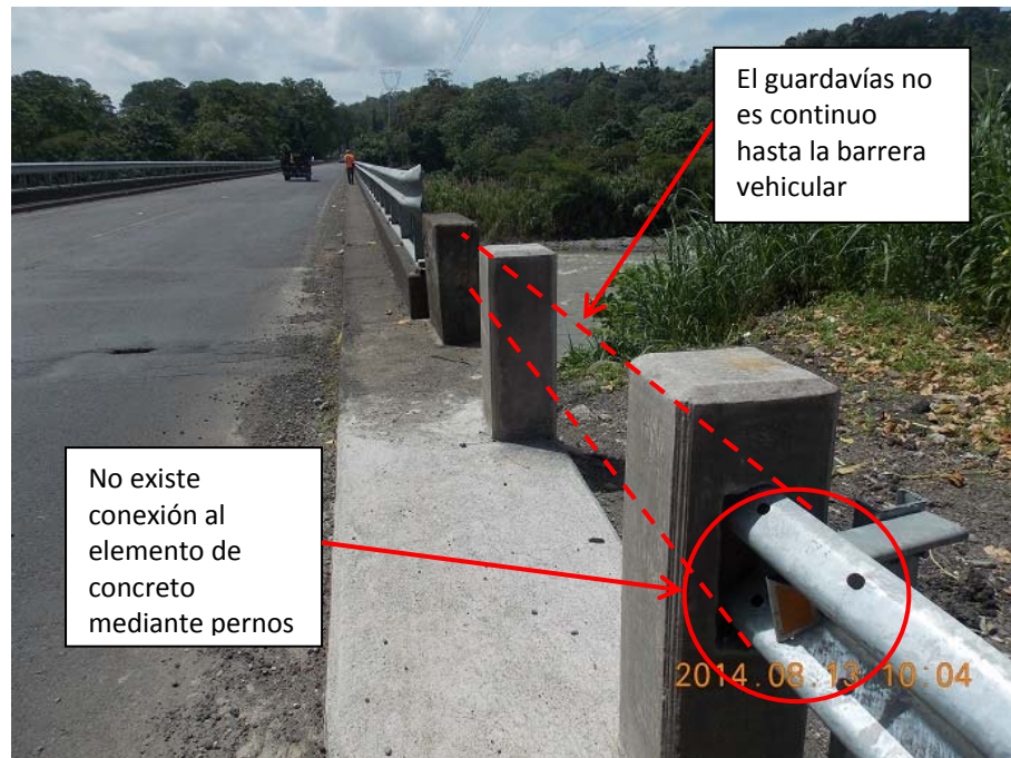
Figura 2: Guardavías del acceso oeste costado sur.
