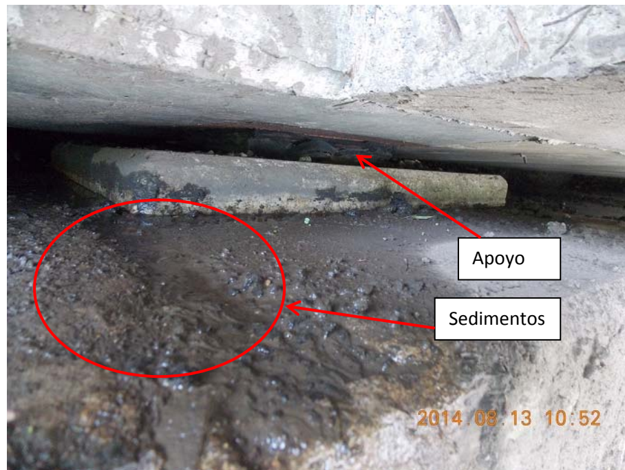
Figura 15: Apoyo en contacto con sedimentos.
