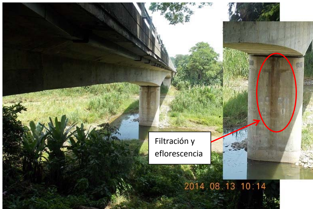
Figura 16: Vista de pila 1 desde el acceso este.
