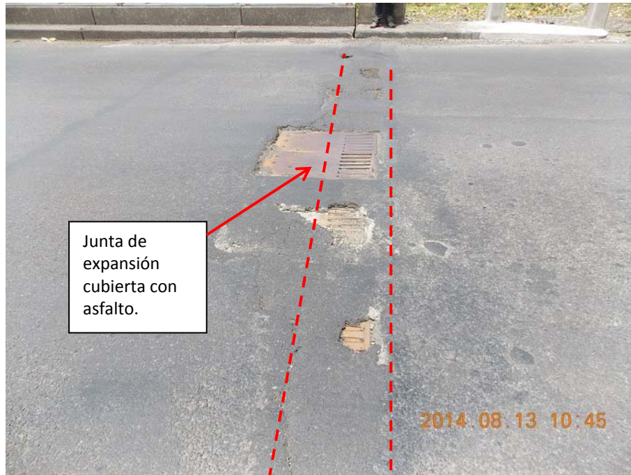
Figura 8: Junta de expansión del acceso oeste.
