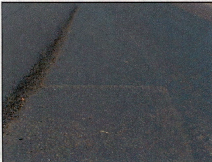
Fotografía 3: Reparaciones de la carpeta existente (Bacheo Menor).
