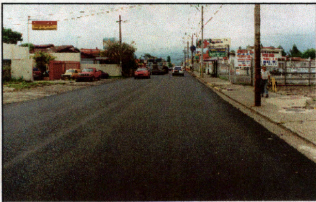
Fotografía 9: Vista general de acabado de sobrecapa.
