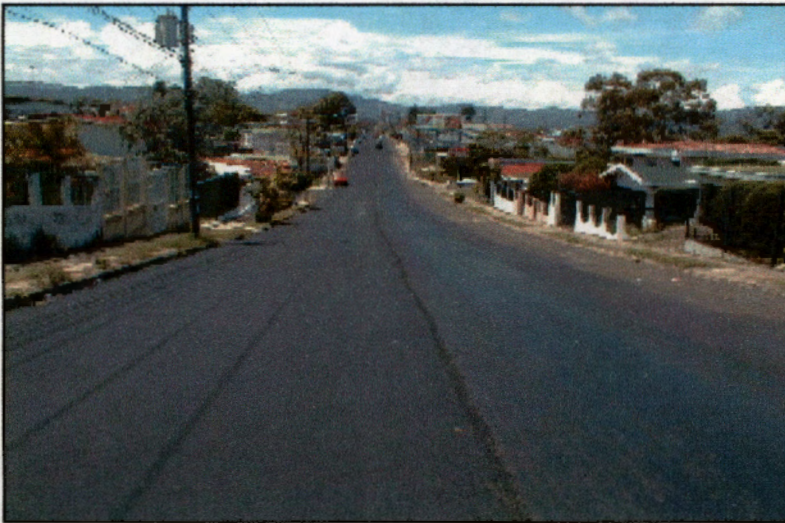
Fotografía 5: Vista general de trabajos de recarpeteo.
