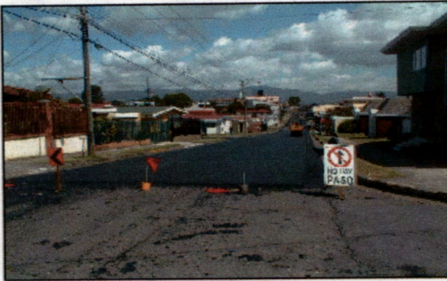
Fotografía 4: Vista general de calle recarpeteada. Nótese señalamiento para cierre de vía.
