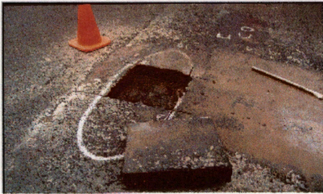
Fotografía 1: Trabajos de extracción de bloque de sobrecarga para análisis de LANAMME.
