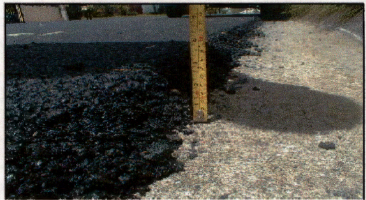
Fotografía 11: Chequeo de espesor de la sobre capa, espesor aproximado 5.0 cm.
