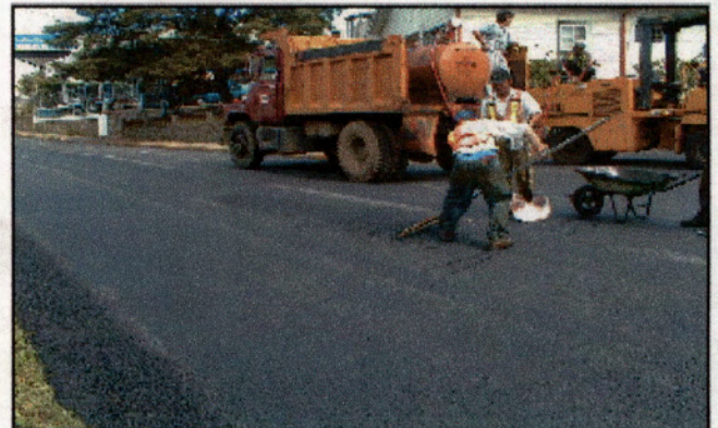
Fotografía 2: Trabajos de corrección de acabado superficial, pos colocación de sobre capa.
