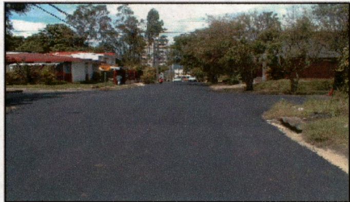
Fotografía 8: Vista general de trabajos de recarpeteo, nótese buen acabado de bocas de calle.
