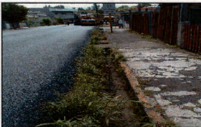
Fotografía 3: Acabado final de borde de sobre capa
