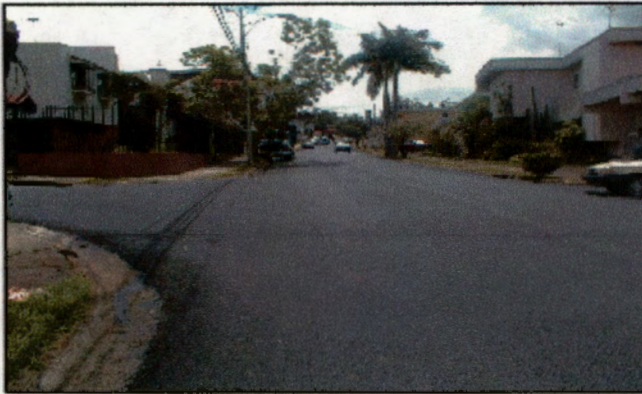
Fotografía 1: Vista general de los trabajos de recarpeteo de la ruta Pops-C.C. Plaza Cristal. Se presenta detalle del acabado en las boca-calles
