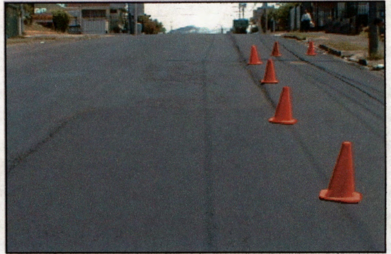
Fotografía 4: Avance de recarpeteo. Nótese el estado de la vieja carpeta.
