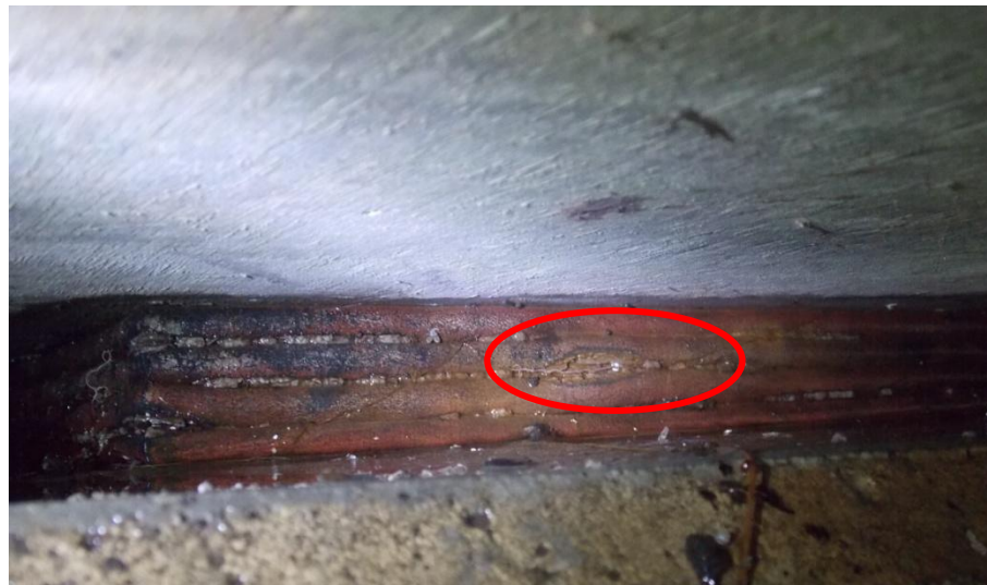
Figura 15. Rotura superficial y abultamiento en almohadillas elastoméricas.
