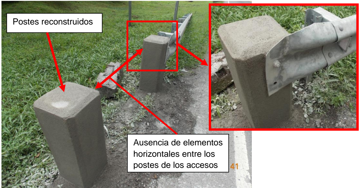
Figura 1. Detalles de anclaje de los guardavías al poste reconstruido en el acceso 2 (lado aguas arriba)
