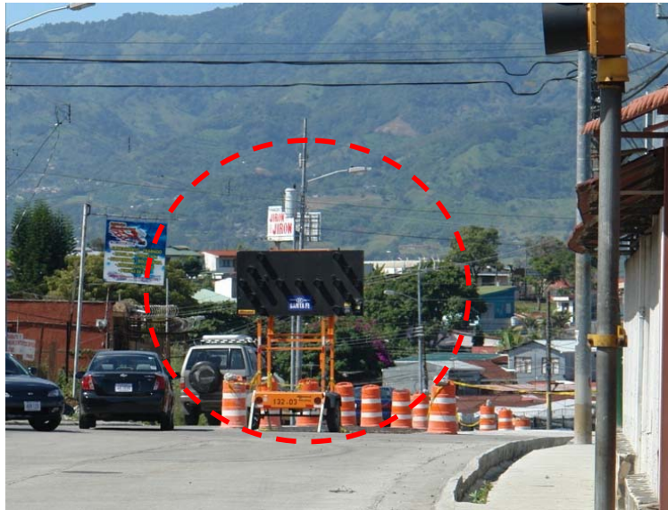
Fotografía 3. Señalización al inicio de la zona de trabajo. No se observa transición de convergencia. Proyecto Zapote – San Francisco. Fecha de visita 16/10/09
