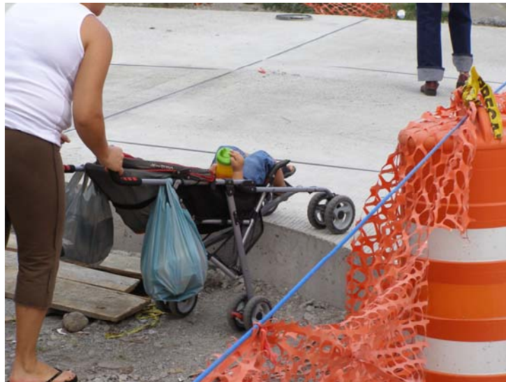
Fotografía 12. Ausencia de facilidades peatonales en la zona de trabajo. Fecha de visita 16/10/09
