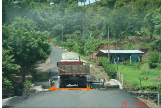
Fotografía N° 10: Puente angosto muy deteriorado.
