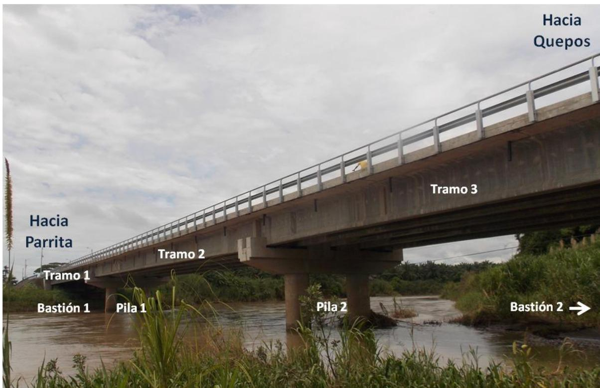
**Figura D.** Identificación utilizada para el puente sobre el Río Parrita.
