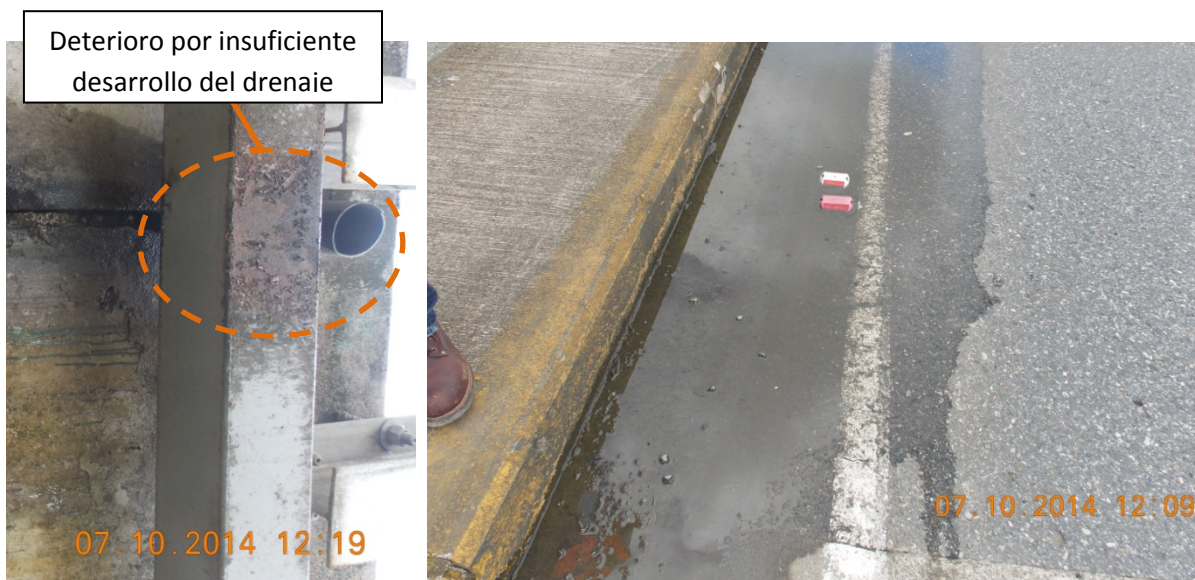
Figura 6: Extensión insuficiente del tubo de drenaje y acumulación de agua y sedimentos en los bordillos.
