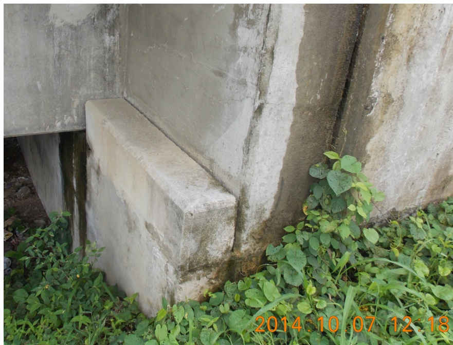
Figura 14: Detalle de unión superestructura-bastión.
