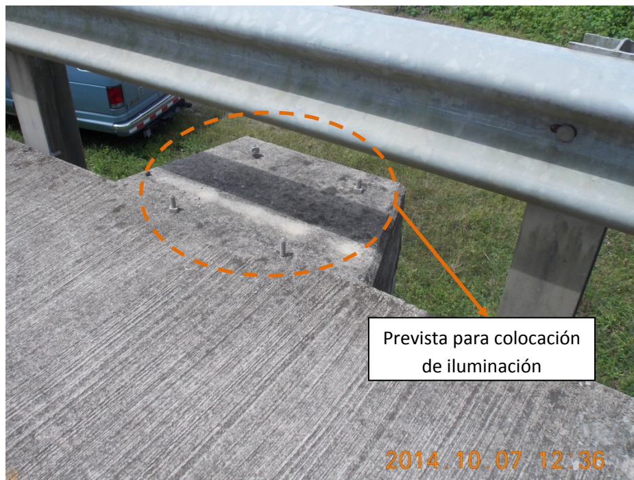
Figura 4: Prevista para colocar postes de iluminación.
