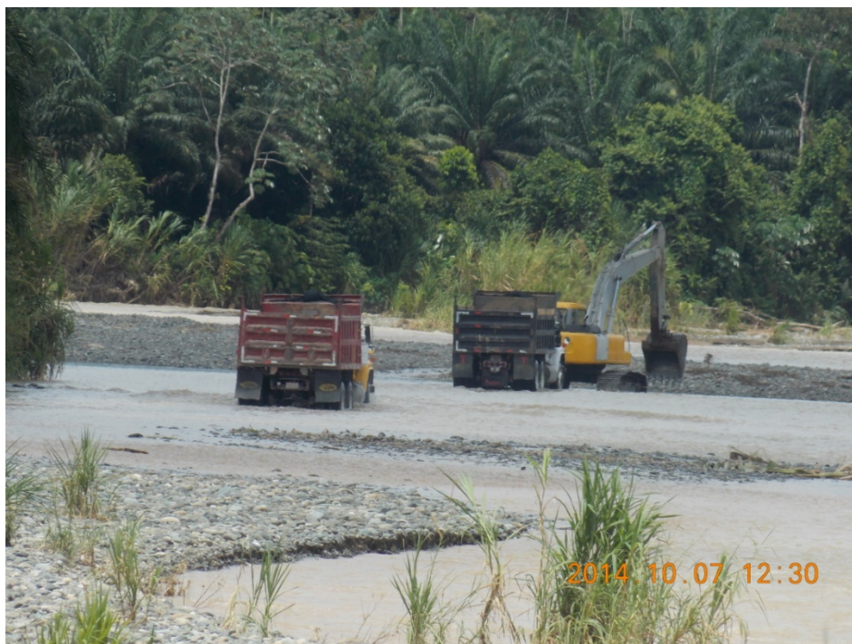
Figura 9: Extracción de materiales en el cauce.
