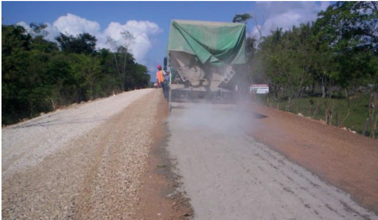
Figura 9. Dosificación del cemento a granel Fuente: SBI International Holdings AG, Guatemala & Latinoamérica
