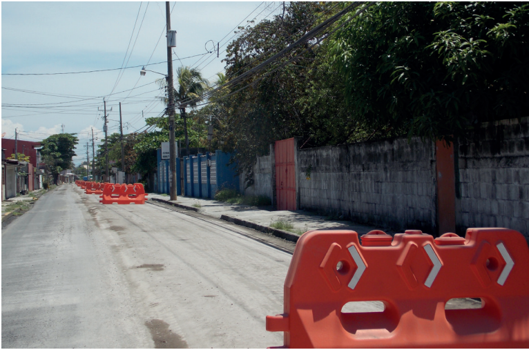
Figura 16. Colocación de barreras para impedir el tránsito vehicular sobre la base estabilizada Fuente: LanammeUCR
