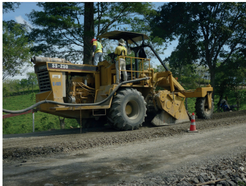
Figura 5. Escarificación de superficie con recuperadora Fuente: LanammeUCR
