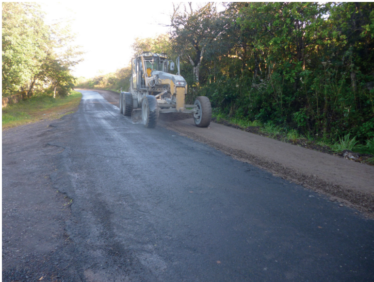
Figura 14. Conformación de una superficie de base estabilizada Fuente: LanammeUCR
