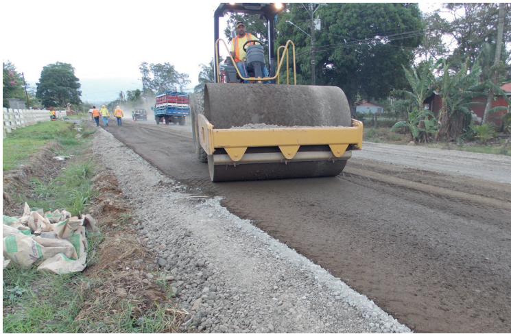
Figura 15. Compactación de base estabilizada con cemento Fuente: LanammeUCR
