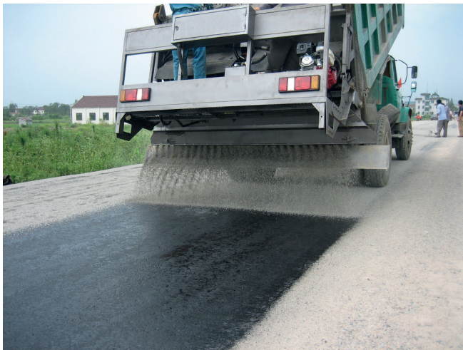
Figura 2. Colocación de material de secado sobre un riego de imprimación Fuente: Metong Portugal, s.f.
