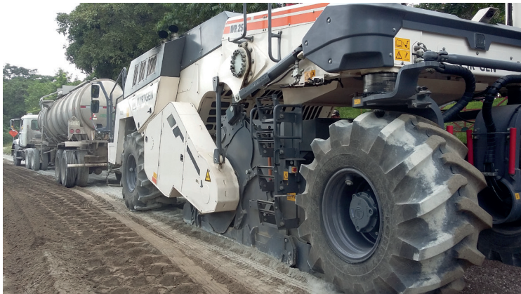
Figura 12. Mezclado de cemento, agua y material de base Fuente: LanammeUCR
