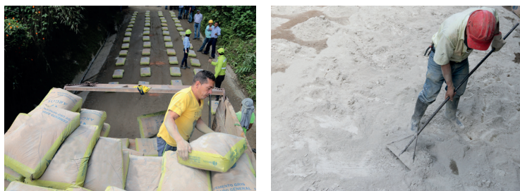
Figura 8. Dosificación de cemento por sacos Fuente: Echeverry, 2016
