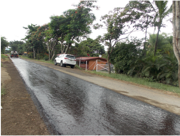
Figura 4. Colocación del riego de imprimación Fuente: LanammeUCR
