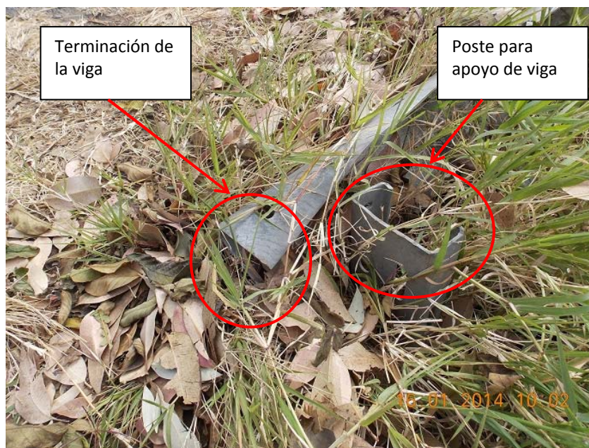
Figura 6: Detalle del anclaje del guardavías en el acceso norte en el costado oeste.
