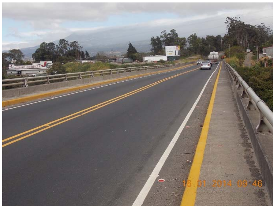
Figura B: Vista a lo largo de la línea de centro desde el acceso sur.
