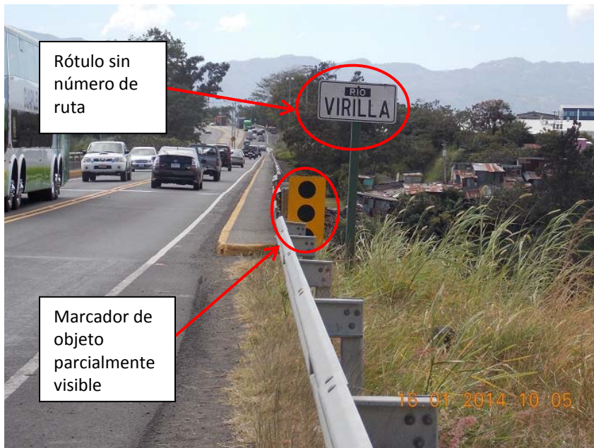
Figura 11: Marcador de objeto con visibilidad parcial y rótulo sin número de ruta en el acceso norte.
