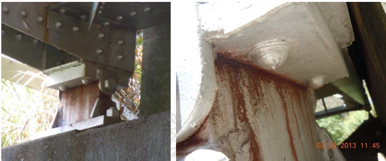
Figura 19: Oxidación en ambos apoyos móviles.
