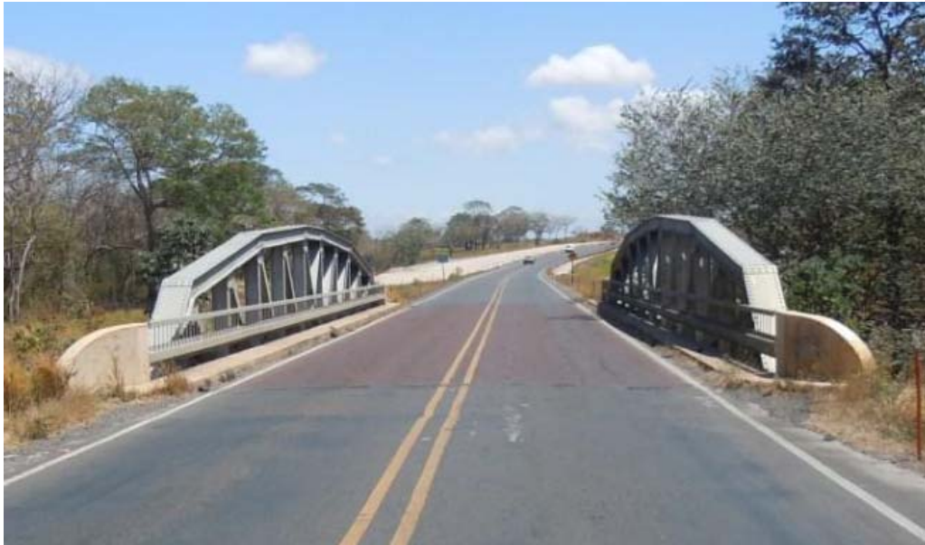
Figura 2: Vista a lo largo de la línea de centro.
