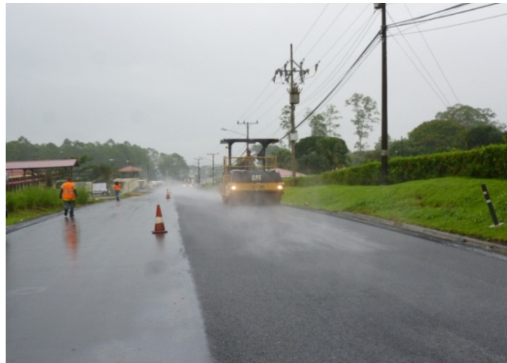
Fotografía 18. Compactación bajo lluvia .
