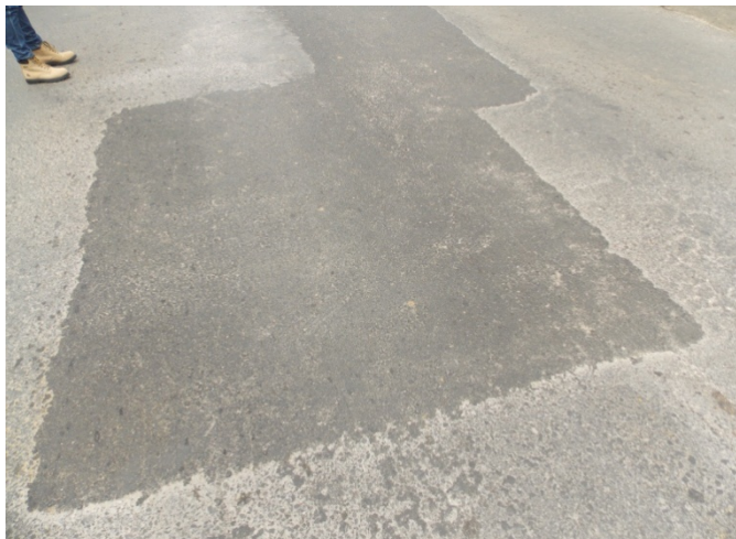
Fotografía 12. Bombeo de finos en intervención realizada Ubicación: sobre ruta de travesía 11501, 75 m Este del Super Tacho, Sección de control 19777, Fuentes de Montes de Oca (R 203)- San Pedro de Montes de Oca(R.2), Fecha 6 de octubre de 2015. Fuente LanammeUCR
