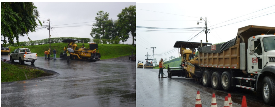
Fotografía 17. Colocación de mezcla asfáltica en caliente bajo condiciones climáticas de lluvia. Ubicación: Sobre la Ruta 812, km 0+000 desde el cruce con la Ruta Nacional 32, Sección de control 70250 Milano(plaza)-Pocora(R.32), Fecha 14 de agosto de 2015. Fuente: LanammeUCR.
