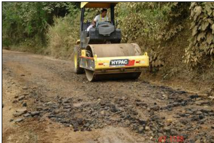
Fotografía No. 1: Compactación de material con fragmentos de concreto asfáltico sobre una ruta de lastre durante la conformación de la calzada. Ruta No.329, sección de control 10852. Fecha de la fotografía 27 de febrero del 2009
