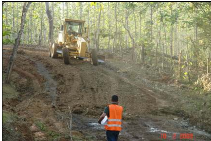
Fotografía No. 5: Conformación de calzada. Ruta Nacional No. 901 sección de control 50671. Fecha de la fotografía 10 de febrero del 2009.
