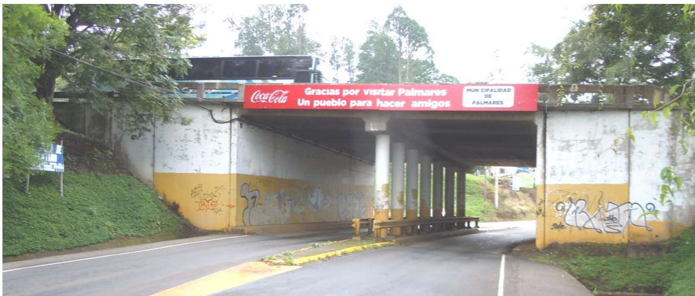
Figura C: Vista lateral del paso a desnivel.
