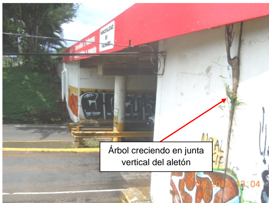
Figura 16: Maleza en junta vertical del aletón.
