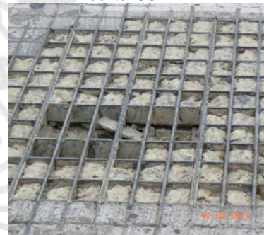
Fotografía 4. Rejilla fracturada debido a la pérdida de concreto
