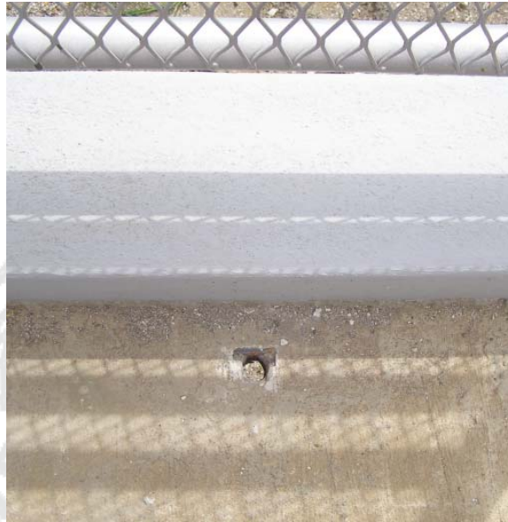
Fotografía 19. Drenajes adicionales de 1.5" (3,75cm), contruïdos en el tablero del puente del lado de acera peatonal.
