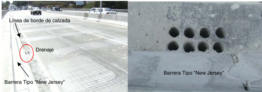
Fotografía 17. Drenajes construidos en el tablero del puente del lado de la calzada.
