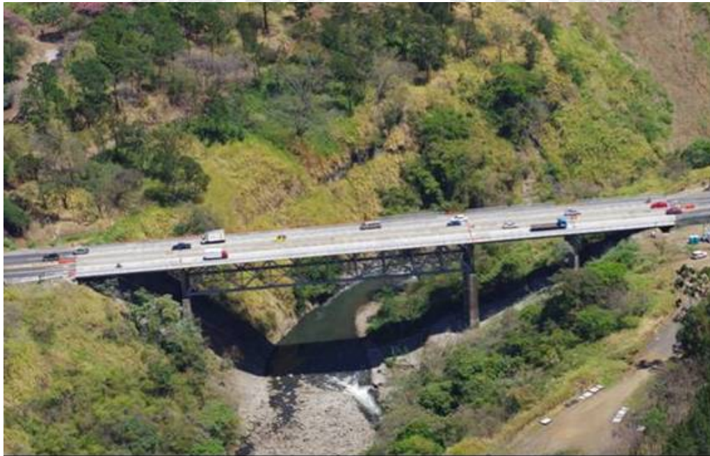
Figura 1. Proyecto Puente sobre el Río Virilla, Ruta N°1. Fuente: CONAVI
