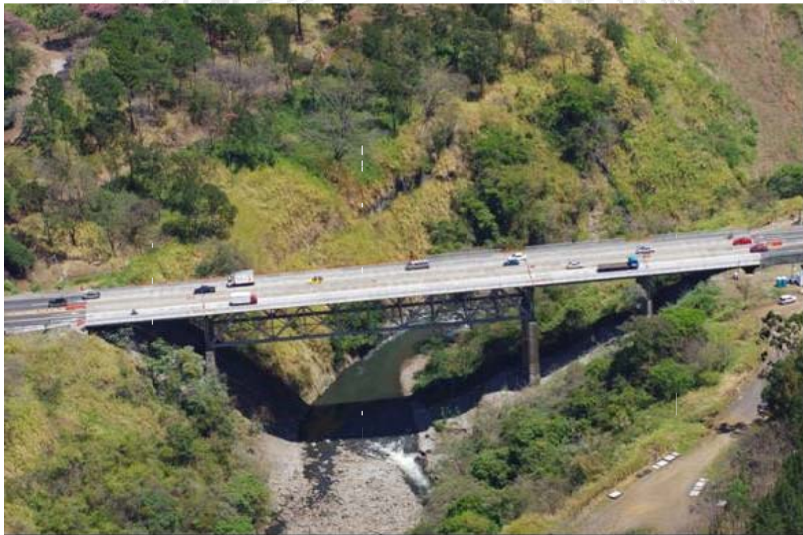
Fotografía 1. Proyecto Puente sobre el Río Virilla, Ruta N°1. (Fuente CONAVI)
