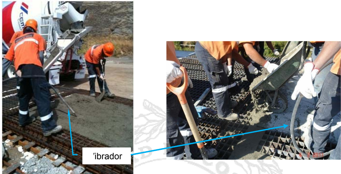
Fotografía 3. Proceso de colocación del concreto en planta y en las uniones de las rejillas en sitio. Fuente: LanammeUCR
