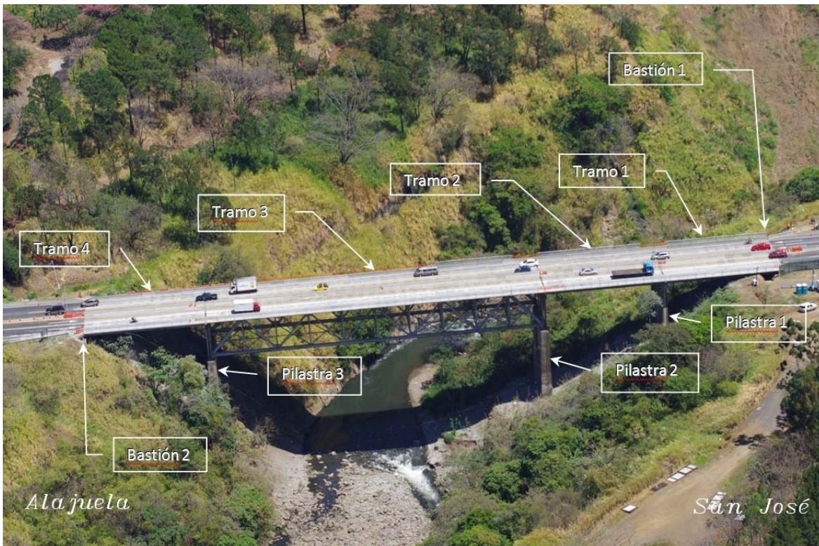
Fotografía 1. Vista aérea del Puente Virilla-RN1 en dirección aguas arriba, hacia el norte.
