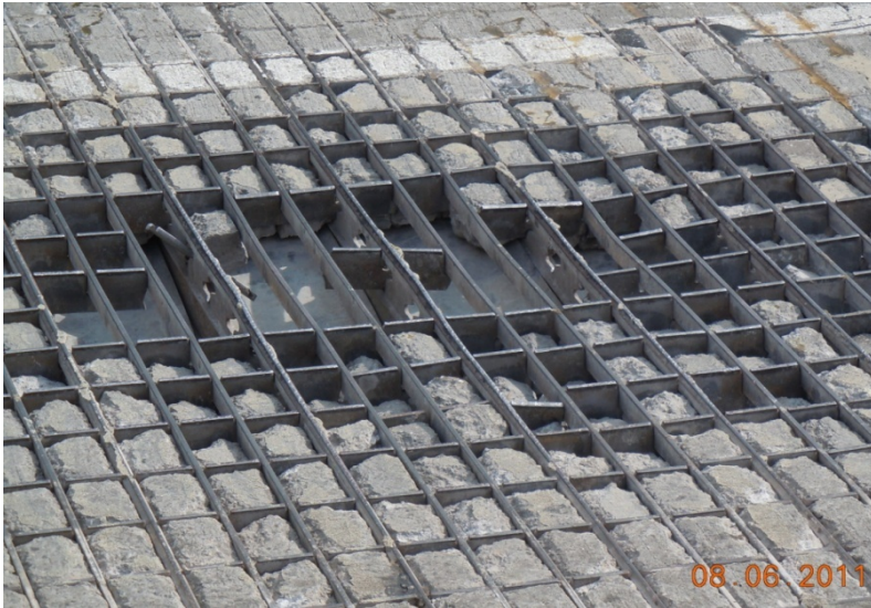
Fotografía 4. Rejilla fracturada debido a la pérdida de concreto
