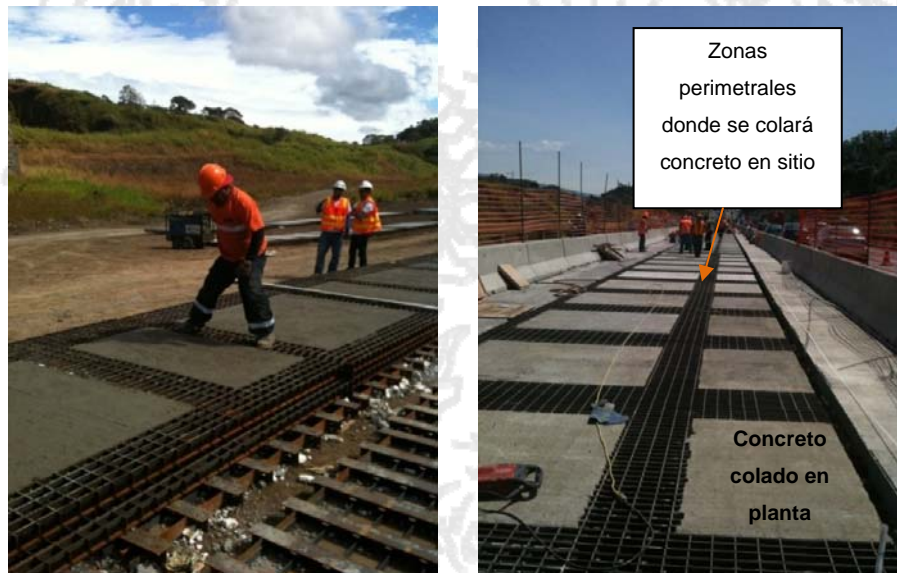
Fotografía 12. Zonas centrales de la rejilla coladas en planta. Fuente: Conavi
