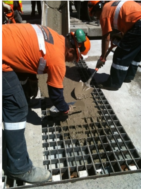
Fotografía 13. Zonas perimetrales de la rejilla coladas en sitio. Fuente: Conavi
