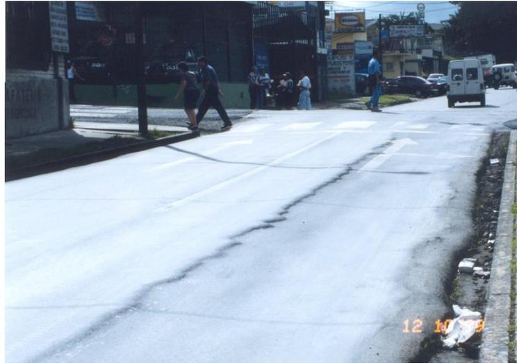
**Figura 11.** Falla por deformación permanente de una mezcla asfáltica.
