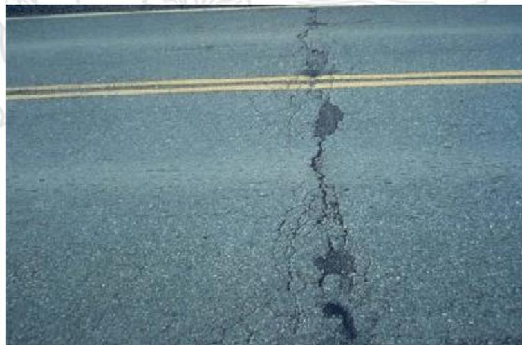
**Figura 13.** Falla por fisuramiento térmico de una mezcla asfáltica.
