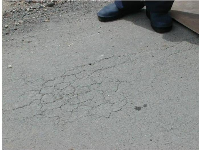
**Figura 12.** Falla de fisuramiento por fatiga de una mezcla asfáltica.
