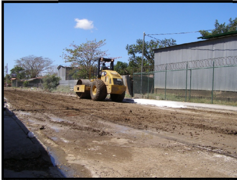
Imagen 8. Compactación del tramo
