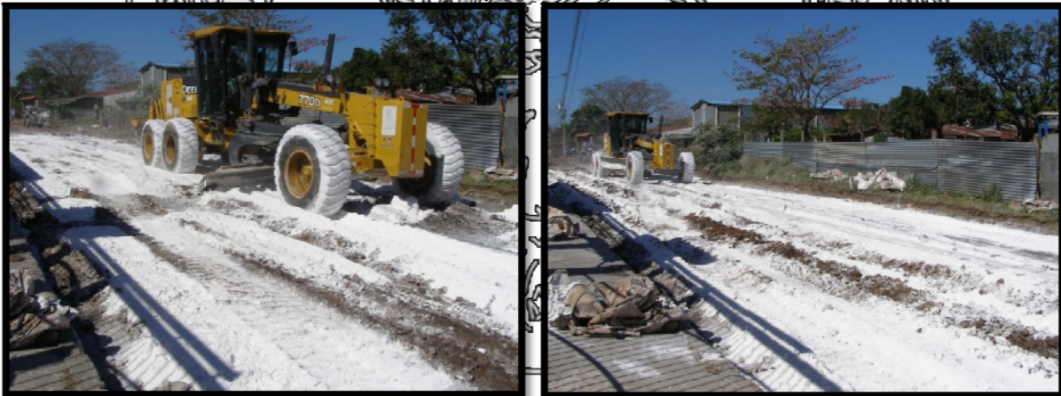
Imagen 5. Mezclado y homogenización de la cal
