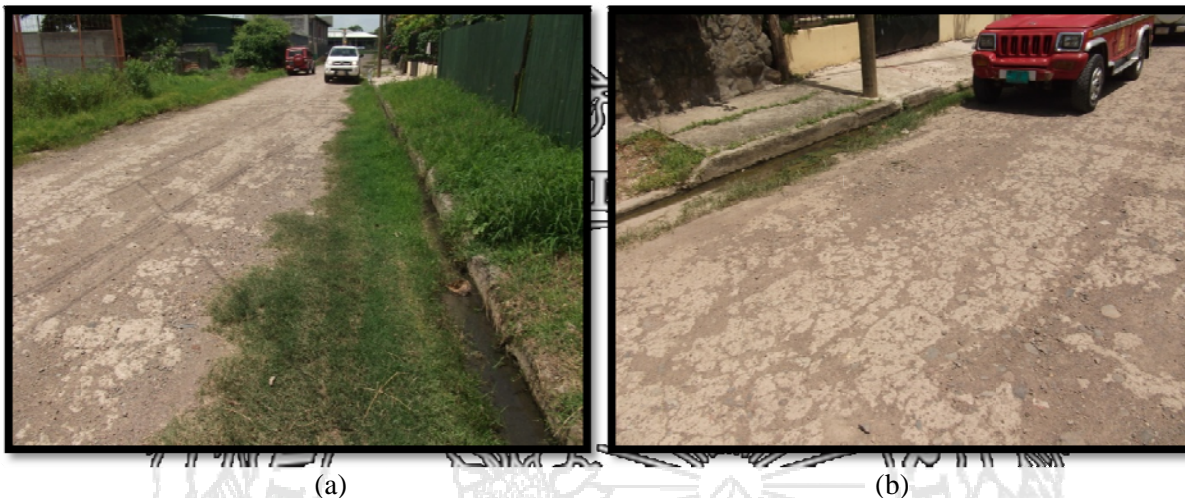
Imagen 17. Condición superficial del tramo, dieciocho meses después (julio 2013)
