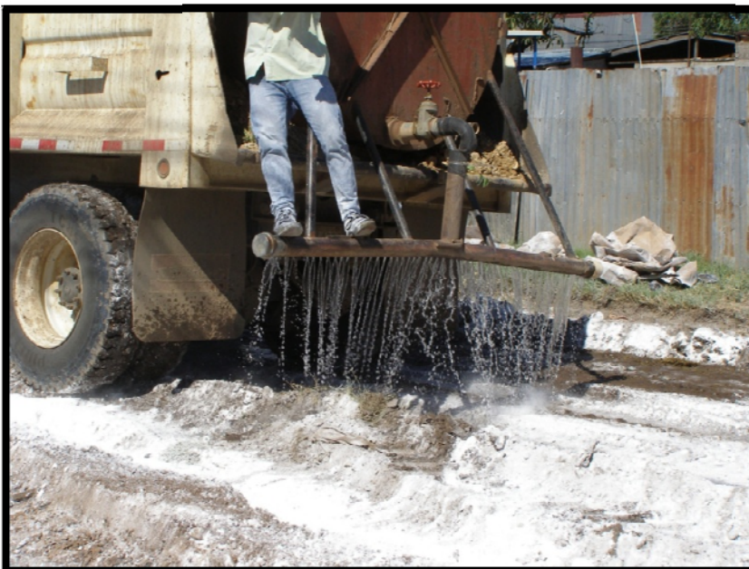
Imagen 6. Adición de humedad de compactación
