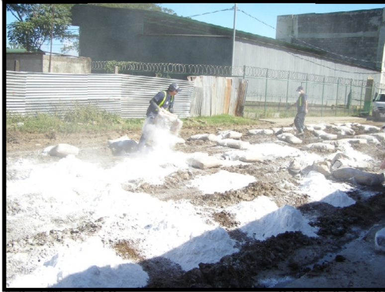
Imagen 4. Extendido de la cal
