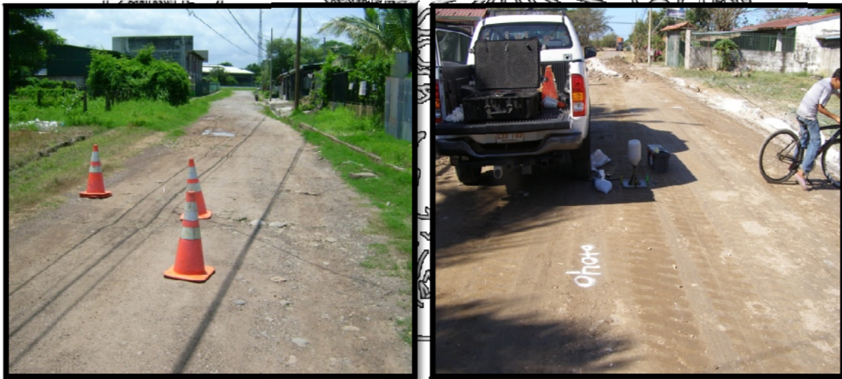
Imagen 9. Comparación del tramo (a) antes y (b) después de la estabilización con cal
