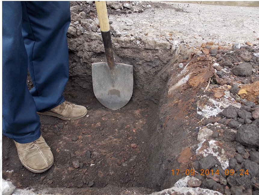
Figura 4. Sondeo en calle de acceso para evaluar material de subrasante.
