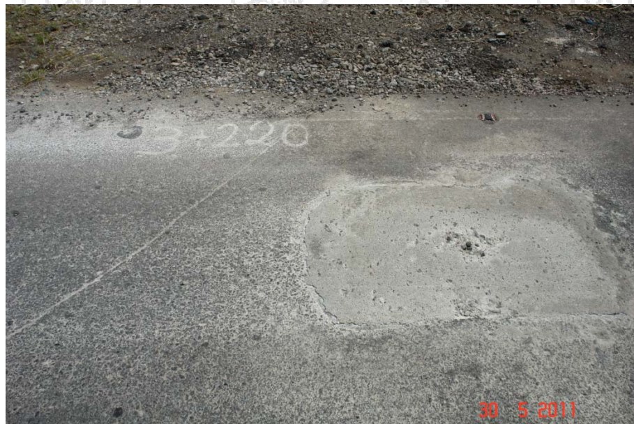
Figura 25. Kilómetro 3+220. Cielos abiertos encontrados en la segunda visita 30 mayo 2011. Carril derecho.
