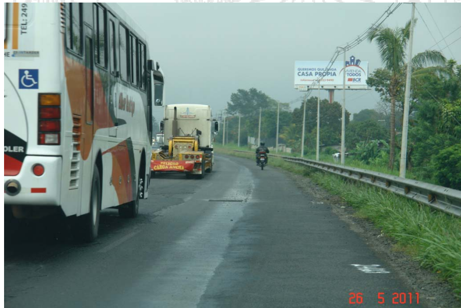
Figura 17. Kilómetro 2+650. Cielo abierto cerrado con mezcla asfáltica el mismo día en horas de la tarde.
