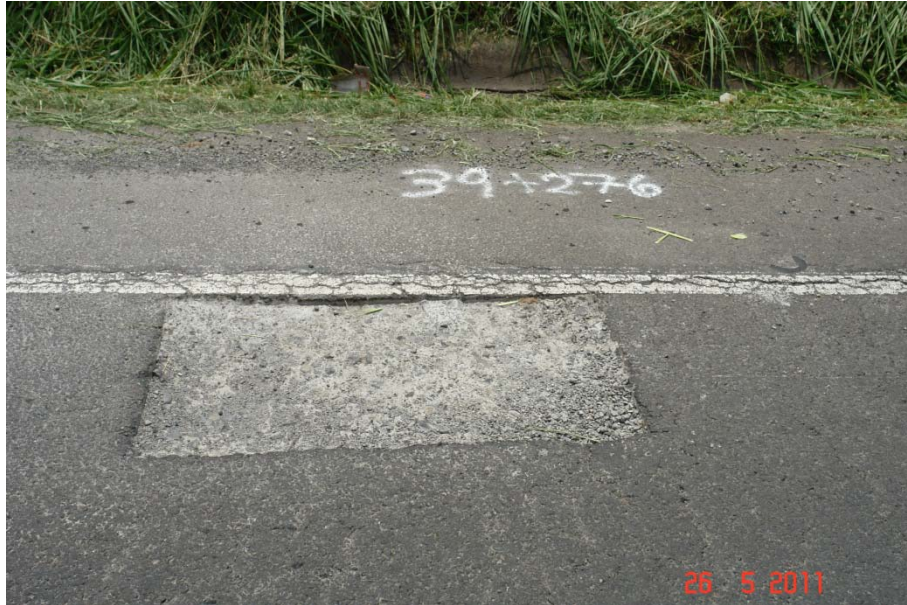
Figura 18. Kilómetro 39+276. Cielo abierto encontrado.
