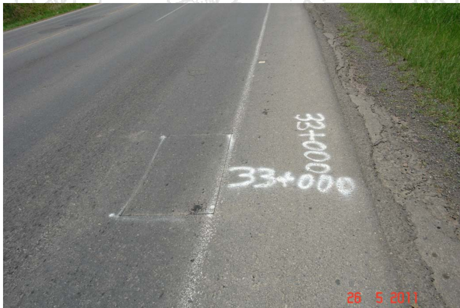
Figura 21. Kilómetro 33+000. Corte para realizar el cielo abierto.
