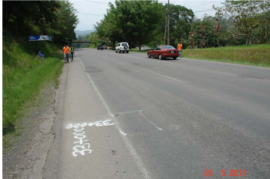
Figura 22. Kilómetro 33+000. Corte para realizar el cielo abierto
