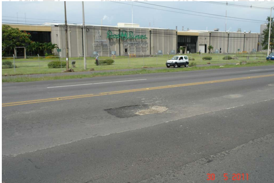
Figura 31. Kilómetro 6+000. Desprendimientos en la cobertura asfáltica colocada. Carril Izquierdo
