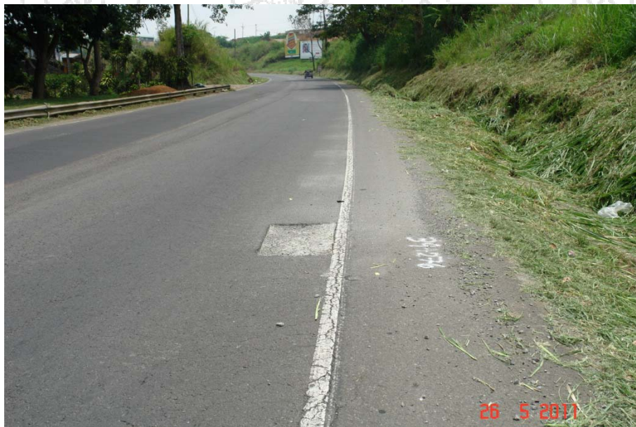
Figura 19. Kilómetro 39+276. Cielo abierto encontrado.
