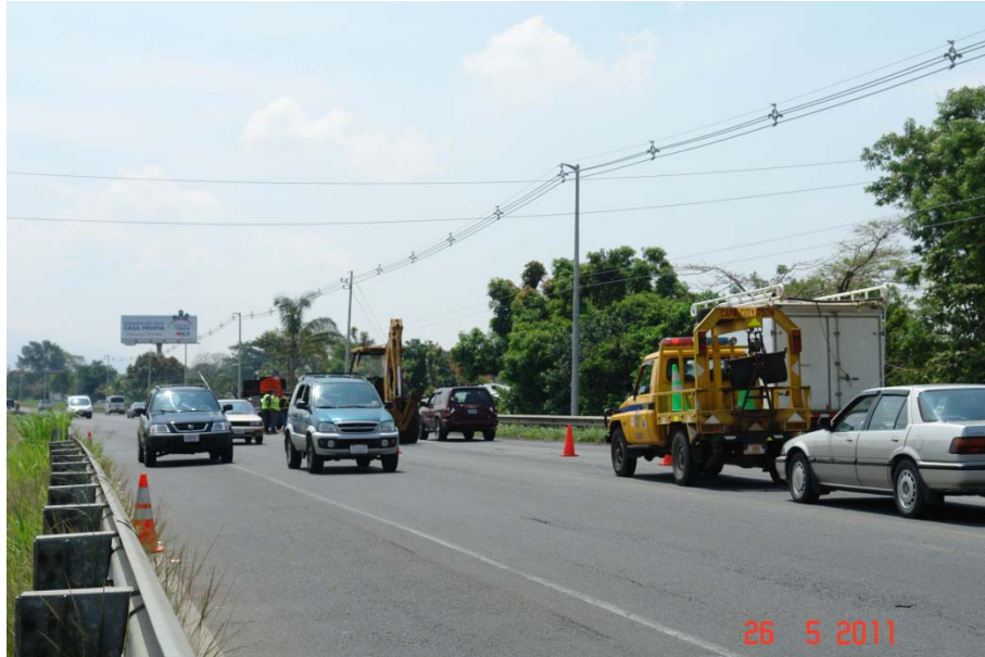
Figura 6. Kilómetro 2+650. Zona de trabajo encontrada. Se estaba trabajando en tapar el hueco que se abrió del sondeo hecho el día anterior.
