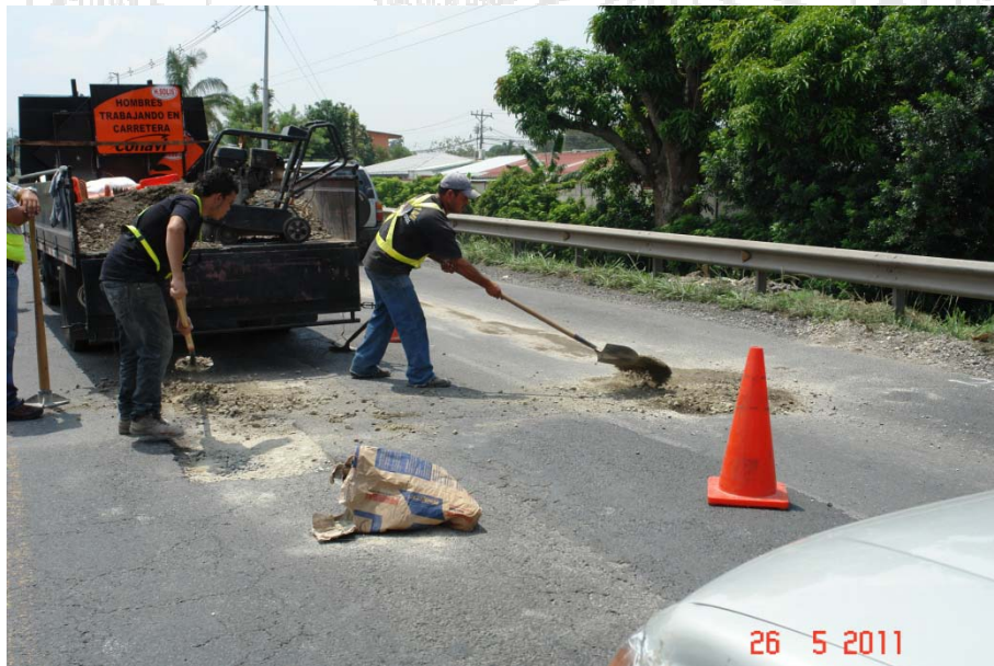
Figura 7. Kilómetro 2+650. Colocación de material sobre los cielos abiertos hechos el día anterior.
