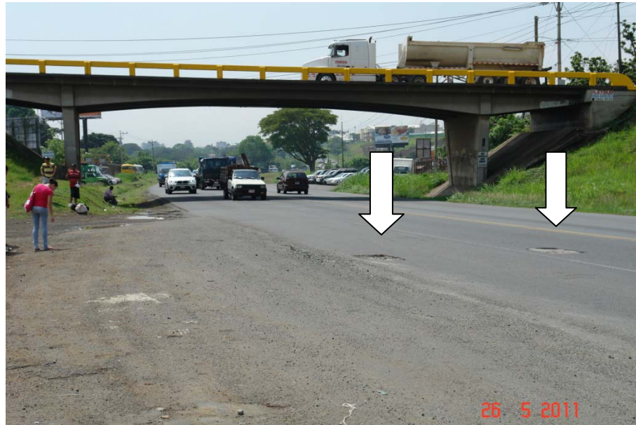
Figura 4. Kilómetro 1+600. Primeros cielos abiertos encontrados.
