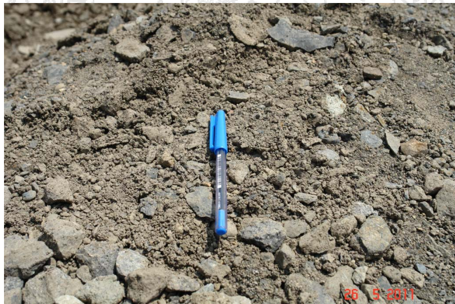
Figura 11. Kilómetro 2+650. Material colocado.
