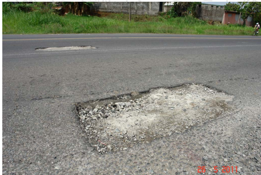
Figura 5. Kilómetro 1+600. Primeros cielos abiertos encontrados.
