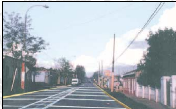
Fotografía D.1. Ejemplo de demarcación alertadora. Fuente: Medidas de Tráfico Calmado (CONASET, 2010).
