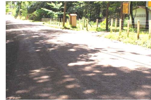
N°9 Roderas con nivel de deterioro bajo Bajo nivel de pérdida de agregado
