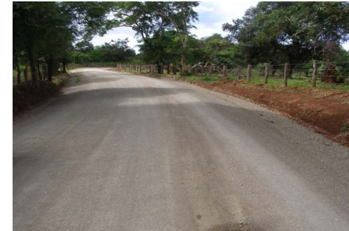
N°3 Buena definición de cuentas se presenta cierta pérdida de agregado con nivel de deterioro bajo
