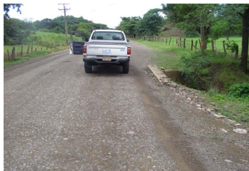
N°1 Estación 2+800 Alcantarilla con longitud menor que el ancho de la calzada
