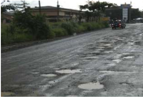
Estación 12+200 a 13+180: agua empozada por lluvias (visita del 29-julio-2010).
