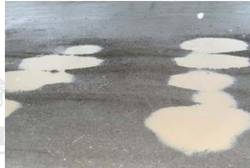
Estación 12+200 a 13+180: agua empozada por lluvias (visita del 29-julio-2010).
