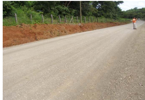
N°2 Acabado superficial existente, en buenas condiciones
