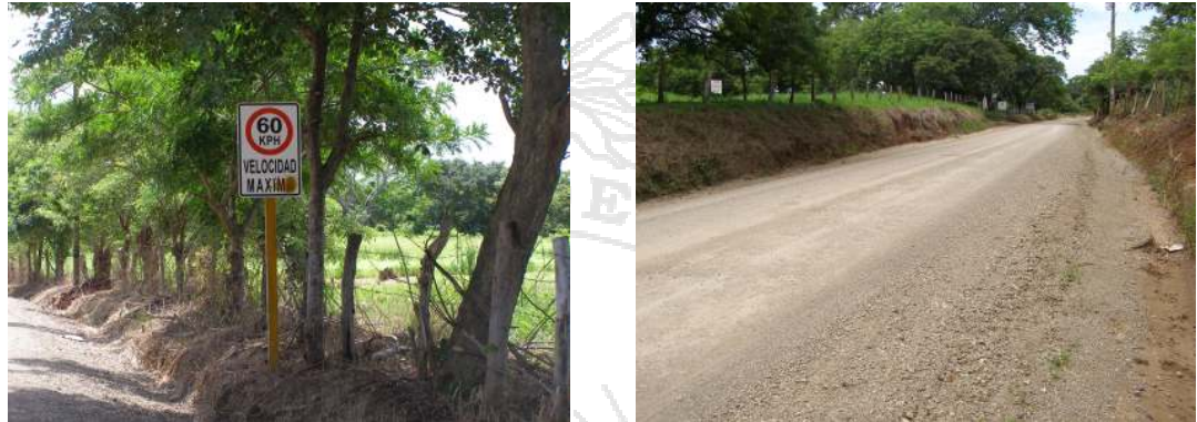
Fotografía N° 5: Camino Vecinal 5-03-067, Hacienda Pinilla-Plaza Paraíso. Km 4+295, buen acabado superficial sin deterioro y buena definición geométrica de cunetas.
