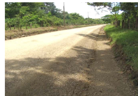
N°21 Acabado superficial existente Buena definición de cunetas pero con material de lastre arrastrado
