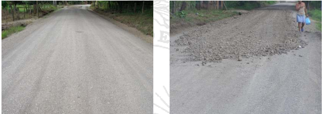
Fotografía N° 3: Camino Vecinal 5-03-067, Hacienda Pinilla-Plaza Paraíso, 1+100 Superficie con algunos huecos pequeños y leve pérdida de material granular.
