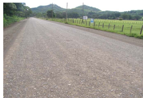
I°4 Estación 6+005, medición de pendiente
