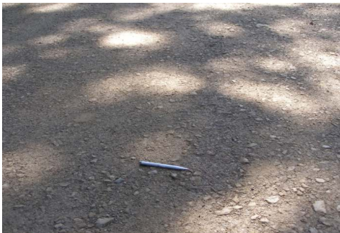
N°10 Granulometría de lastre uniforme
