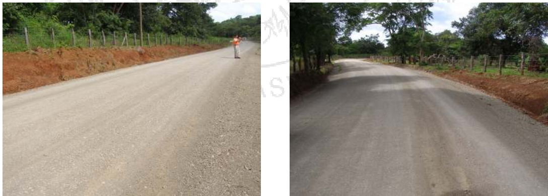
Fotografía N° 4: Camino Vecinal 5-03-067, Hacienda Pinilla-Plaza Paraíso. Km 2+805, buen acabado superficial sin deterioro.
