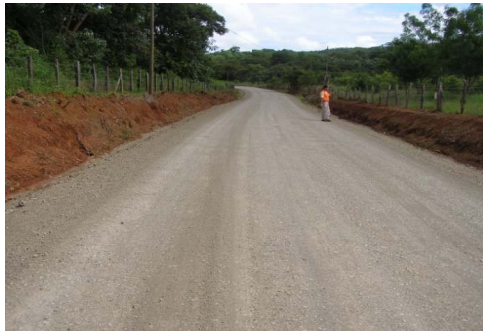
N°1 Acabado superficial existente, en buenas condiciones
