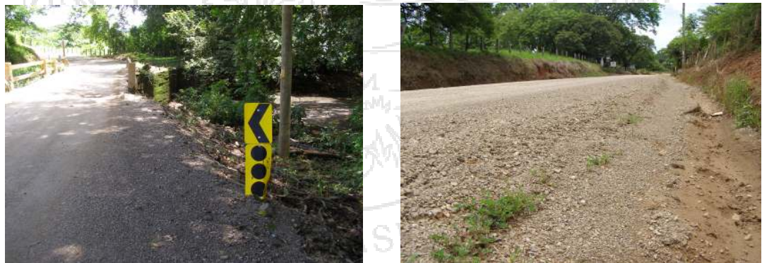
Fotografía N° 6: Camino Vecinal 5-03-067, Hacienda Pinilla-Plaza Paraíso. Km 11+645, buen acabado superficial, buena definición geométrica de cunetas y señalización de estrechez de calzada por puente angosto.
