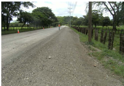
N°19 Cuentas sin buena definición con material de lastre arrastrado
