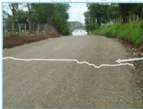
Fotografías N°8B: Material extraído Tajo Líbano mezclado con el del Tajo San Buena, inadecuado acabado de la superficie de ruedo. (Fecha de fotografías 08-Junio-2010)
