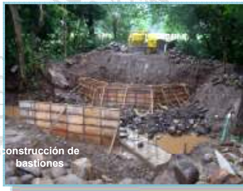
Retiro de losa metálica y construcción de bastiones. (Fecha de fotografías 13-Julio-2010)
