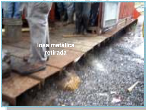
Retiro de losa metálica y construcción de bastiones. (Fecha de fotografías 13-Julio-2010)
