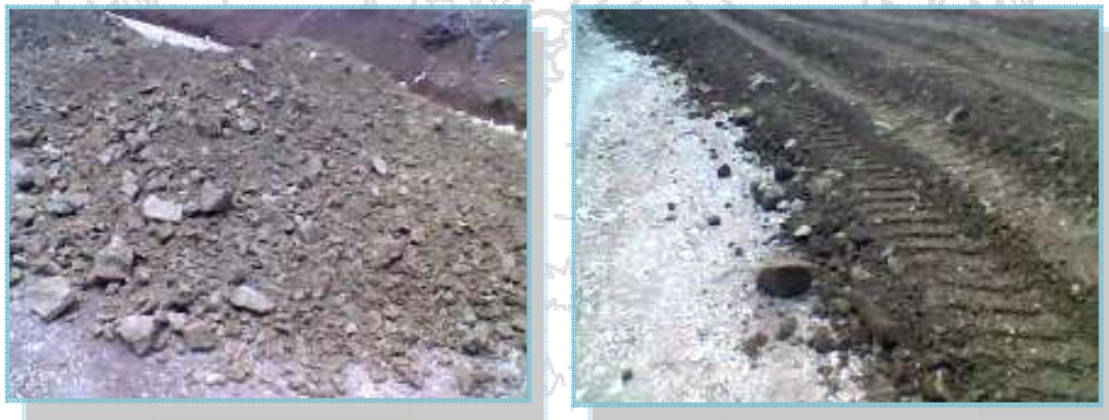
Fotografías N°A: Estación 4+700, Distribución del material extraído del Tajo Líbano sobre el material calizo extraído del Tajo San Buena (colocado el día anterior) (Fecha de fotografía 07-May-2010)
