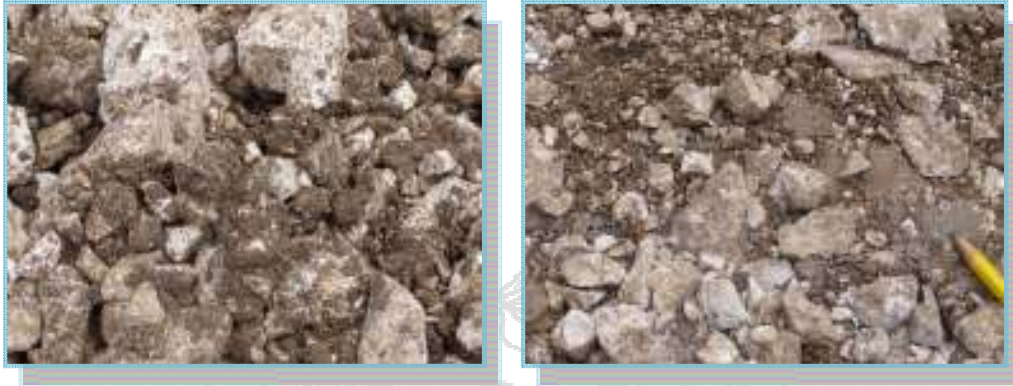
Fotografías N°3: Material calizo extraído del Tajo San Buena, antes de la compactación. Estación 5+150. (Fecha de fotografía 06-May-2010)
