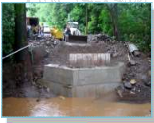
Construcción de bastiones. (Fecha de fotografías 13-Julio-2010)
