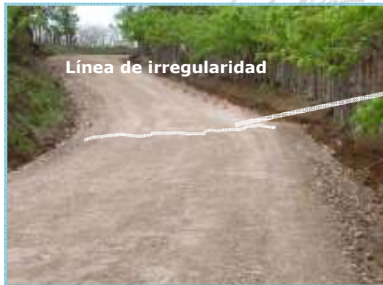
Fotografías N°8A: Material extraído Tajo San Buena, inadecuado acabado de la superficie de ruedo y material suelto. (Fecha de fotografías 06-Mayo-2010)
