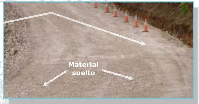
Fotografías N°8A: Material extraído Tajo San Buena, inadecuado acabado de la superficie de ruedo y material suelto. (Fecha de fotografías 06-Mayo-2010)
