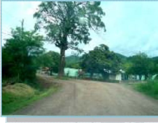
Árbol de grandes dimensiones que representa un obstáculo rígido, sin señalización preventiva Estación 0+060
