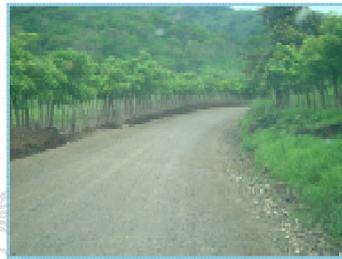
A) Materiales homogenizados provenientes del Tajo Líbano y Tajo San Buena, con inadecuada pendiente transversal. (Fecha de fotografías 08-Junio-2010)
