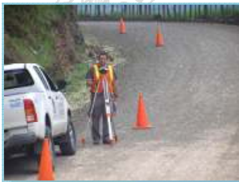
B) Medición de pendiente transversal a material finalmente colocado (mezcla de material de los tajos Líbano y San Buena), Estación 5+305. (Fecha de fotografías 13-Julio-2010)
