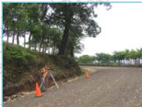
B) Medición de pendiente transversal a material finalmente colocado (mezcla de material de los tajos Líbano y San Buena), Estación 5+305. (Fecha de fotografías 13-Julio-2010)
