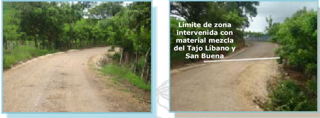
Fotografías N°9: Tramo con material calizo al día del 08-Junio-2010, Estación 5+300. (Fecha de fotografías 08-Junio-2010)
