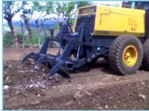
Fotografías N°6B: Estación 4+700, Proceso de homogenización de materiales provenientes del Tajo Líbano y Tajo San Buena. (Fecha de fotografía 07-May-2010)
