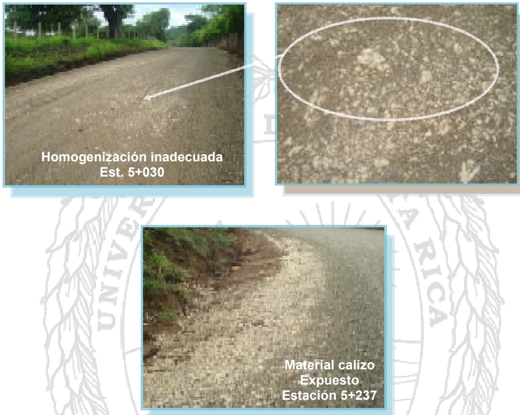
Fotografías N°7: Materiales procedentes de Tajo Líbano y Tajo San Buena, cuya distribución no es uniforme. (Fecha de fotografías 08-Junio-2010)
