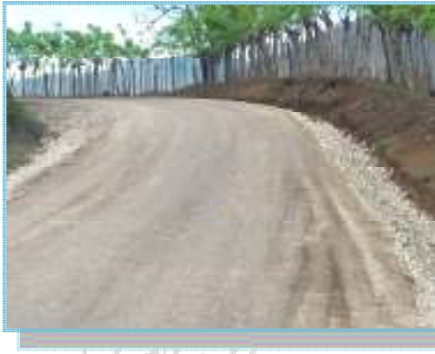
Fotografías N°11: Desechos de material calizo procedente del Tajo San Buena, acumulado en las cunetas y sin retirar. (Fecha de fotografías 06-Mayo-2010)
