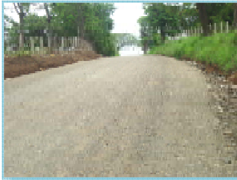
A) Materiales homogenizados provenientes del Tajo Líbano y Tajo San Buena, con inadecuada pendiente transversal. (Fecha de fotografías 08-Junio-2010)
