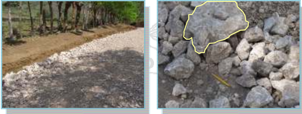
Fotografías N°1: Material calizo extraído del Tajo San Buena, con sobre-tamaño (mayor a 3 pulgadas), Estación 5+150. (Fecha de fotografía 06-May-2010)
