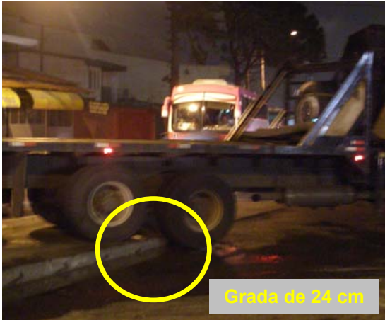
Fotografía 4.23. Bordes de losas de concreto sin señalización; se forman gradas en la vía. (Fecha: 26 de junio del 2009)
