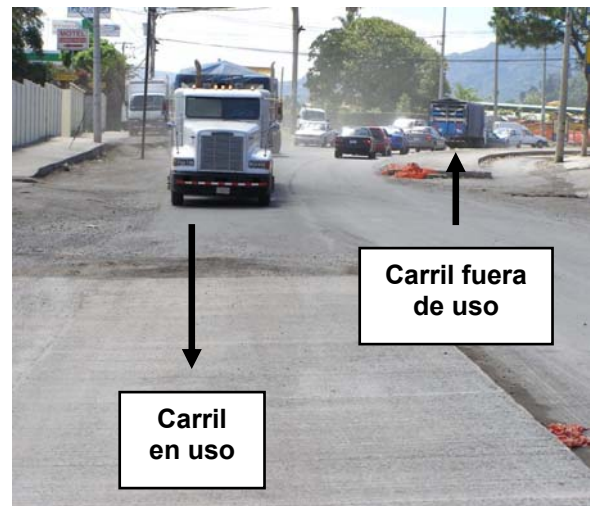
Fotografía 4.16. Falta de señalización genera confusión para los usuarios de la vía. (Fecha: 20 de mayo del 2009)
