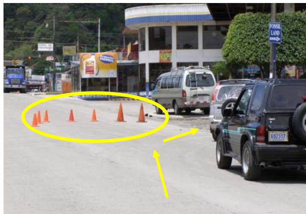
Fotografía 4.5. Configuración de conos que indican desvío en la vía. (Fecha: 20 mayo 2009)
