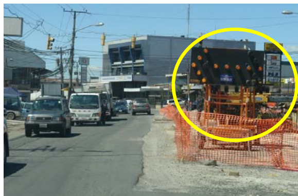
Fotografía 4.11. Utilización de señales luminosas en el proyecto. (Fecha: 2 de febrero del 2009)
