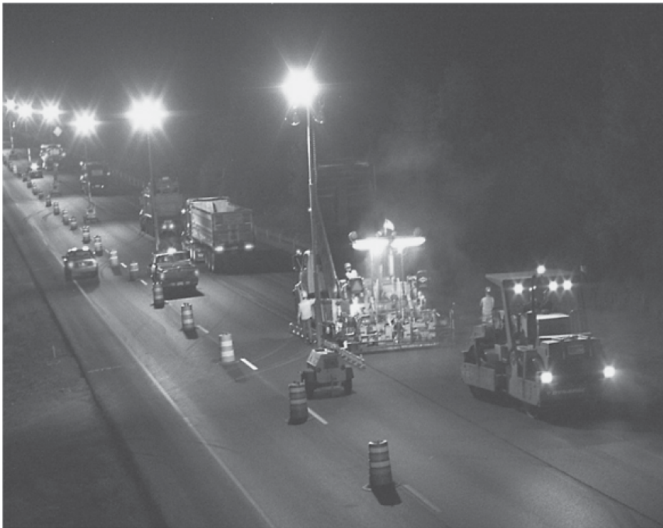
Figura A.1. Trabajos en carretera en horas de la noche.
