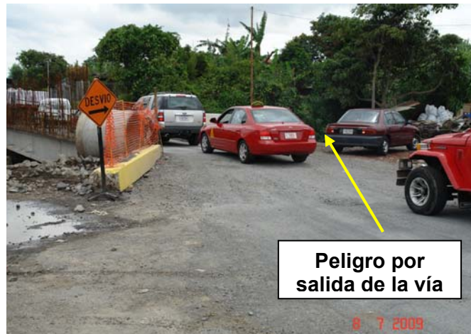
Fotografía 4.7. Puente con solo un carril habilitado, sin un adecuado manejo del tránsito. (Fecha: 8 de julio del 2009)
