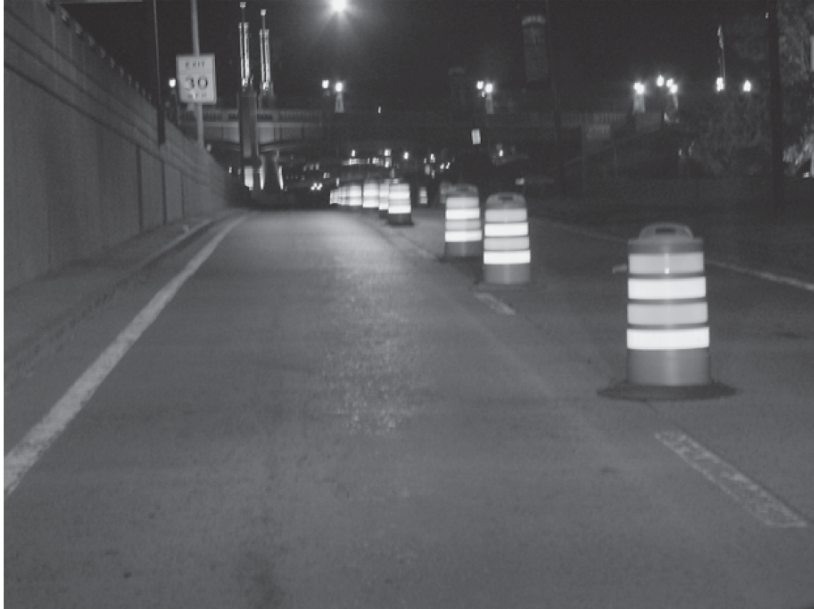
Figura A.2. Canalización del tránsito en la noche. Dispositivos adecuados (tambores o estañones), retrorreflectividad adecuada, espaciamiento adecuado y en buen estado.
