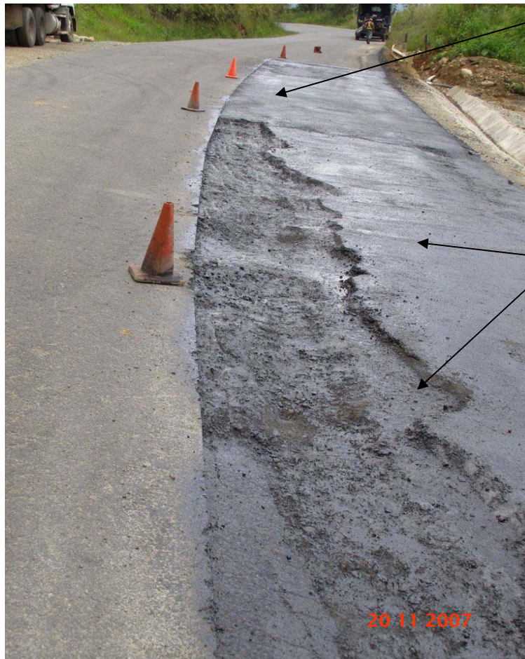
Fotografía No. 8: Superficie irregular con diferentes espesores donde es colocada la mezcla asfáltica en caliente de una vez. La parte más alejada fue colocada el día anterior, está aproximadamente un centímetro por debajo del nivel y sería completada en ese momento. Zona 4-1, Ruta 2 sección de control 10020.
