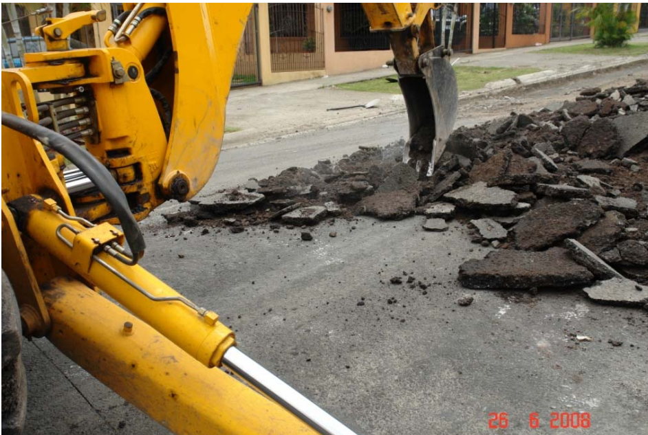
Fotografía No. 26: Corte de carpeta asfáltica en lugar donde no se observa ningún deterioro.
