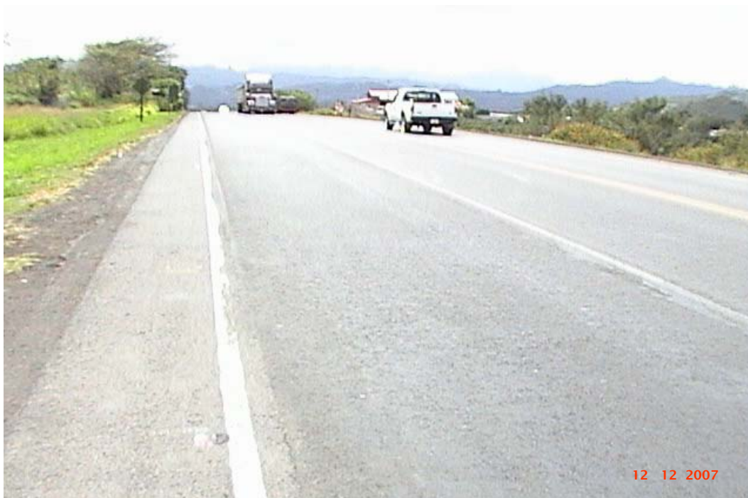
Fotografía No. 5: Área pavimentada después de un perfilado en todo el carril derecho en la Zona 1-5 (Naranjo, Alajuela, San Ramón y Palmares) Ruta No. 1, Sección de Control 20031, cerca del peaje de Naranjo en noviembre de 2007.
