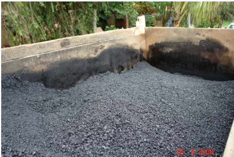
Fotografía No. 28: Vagoneta la cual se había extraído material para llevar a otro lugar y permanecía destapada en espera de que se terminaran los trabajos de excavación y preparación de la base para la colocación de la mezcla.
