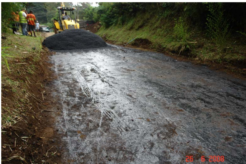
Fotografía No. 21: Bacheo en la Ruta 114, sección de control 40410 de Birri hacia Porrosati, en Heredia. Colocación de mezcla asfáltica sobre terreno sin estructura de pavimento en lugar donde no hay evacuación de las aguas por no existir cunetas.
