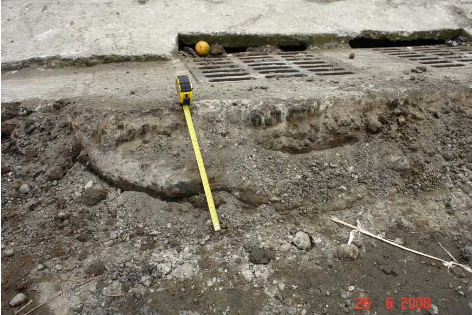
Fotografía No. 25: Altura de excavación donde será colocada la mezcla asfáltica para llegar al nivel de la superficie.
