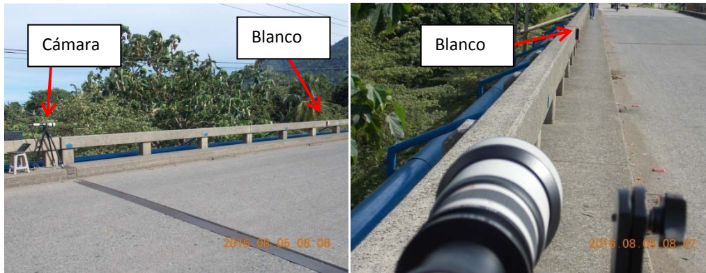
Figura 22. Posición de la cámara y trípode para el centro del tramo 3 (P2 en Figura 4).
