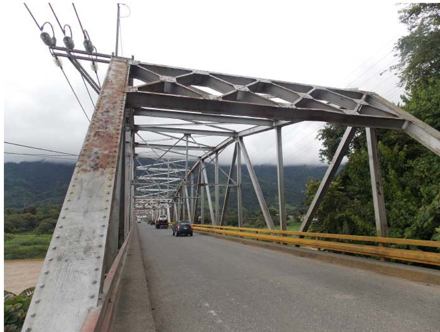
Figura 2. Vista a lo largo de la línea de centro desde el acceso Sur.
