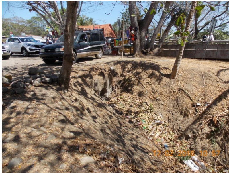
Figura 8. Salida de drenaje del acceso
