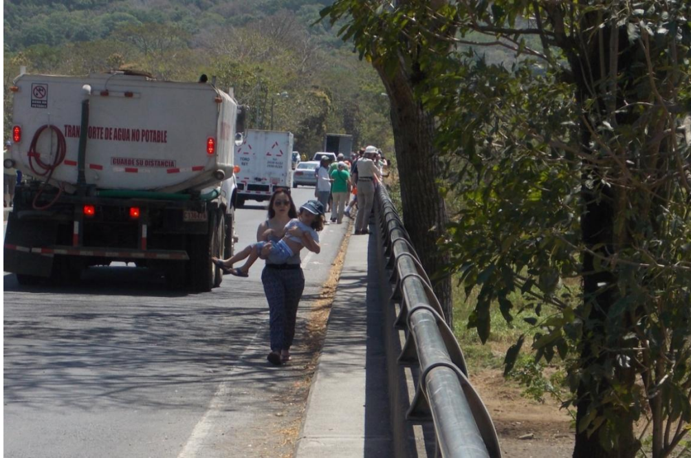
Figura 3. Presencia abundante de peatones en el puente y acera de ancho insuficiente.
