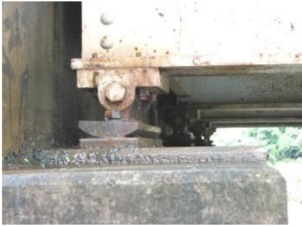
Figura 1.24 Apoyo expansivo tipo patín
