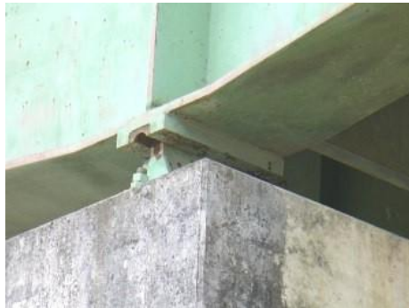
Figura 6-37 Movimiento del apoyo (grado 5)
