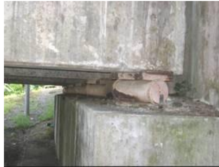
Figura 1.25 Apoyo expansivo tipo rodillo
