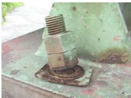
Figura 6-33 Deformación del perno
