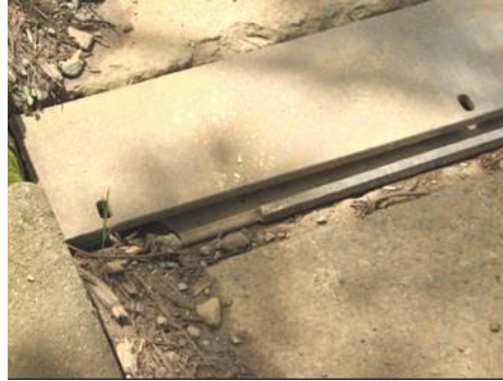
Figura 6-12 Movimiento vertical de la junta de expansión
