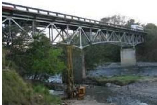
Figura 1.16 Cercha paso superior
