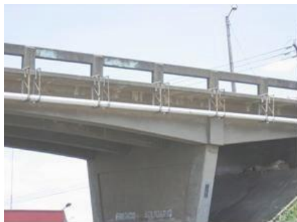
Figura 1.29 Apoyo rígido (concreto)
