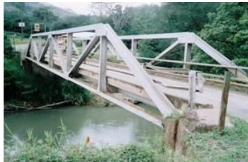
Figura 1.18 Puente tipo pony
