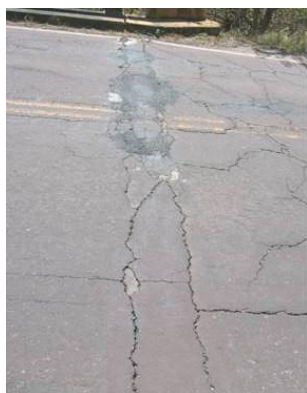
Figura 6-13 Sobrecapas sobre las juntas de expansión (grado 5)
