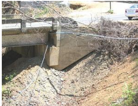
Figura 6-38 Relleno de aproximación
