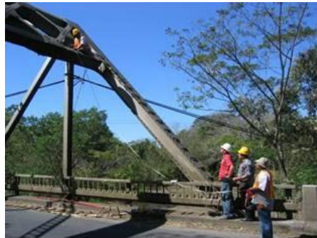
Figura 2-8 Actividades de inspección en alturas
