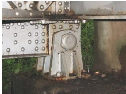
Figura 1.27 Apoyo fijo de acero
