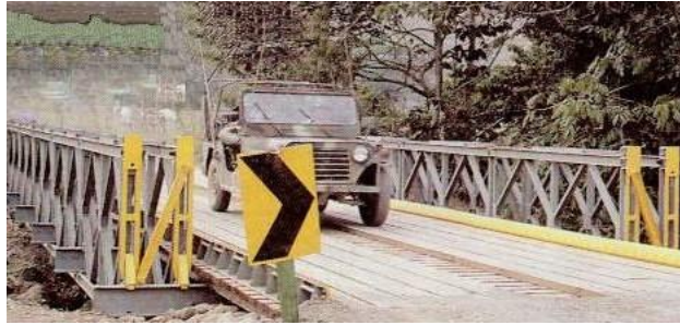
Figura 1.17 Puente tipo bailey
