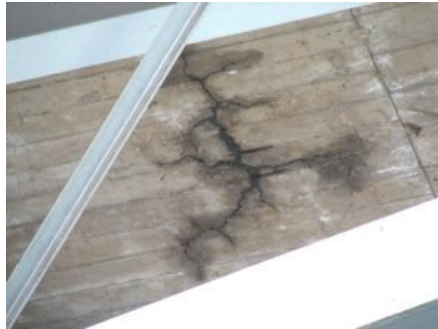
Figura 6-15 Grietas en dos direcciones
