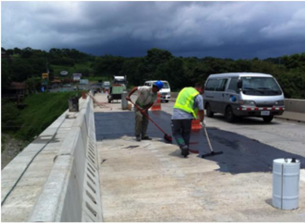
Figura 3. Colocación de la imprimación sobre el tablero del puente sobre el río Aranjuez. Fuente: Fonseca-Chaves, 2011
