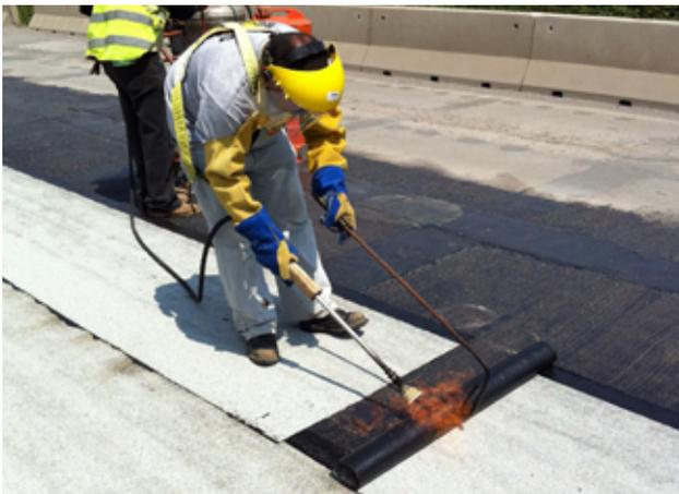
Figura 5. Uso de soplete para propiciar la adhesión de la membrana a la losa. Fuente: Fonseca-Chaves, 2011
