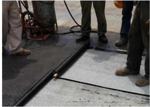
Figura 4. Instalación de la membrana impermeabilizante sobre el tablero del puente sobre el río Aranjuez. Fuente: Fonseca-Chaves, 2011
