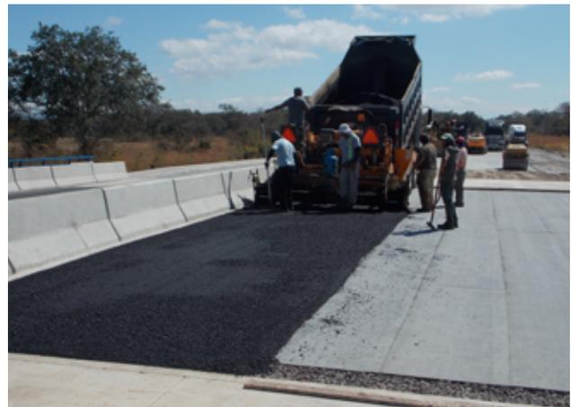
Figura 6. Colocación de la sobrecapa asfáltica sobre la membrana impermeabilizante. Fuente: Fonseca-Chaves, 2011
