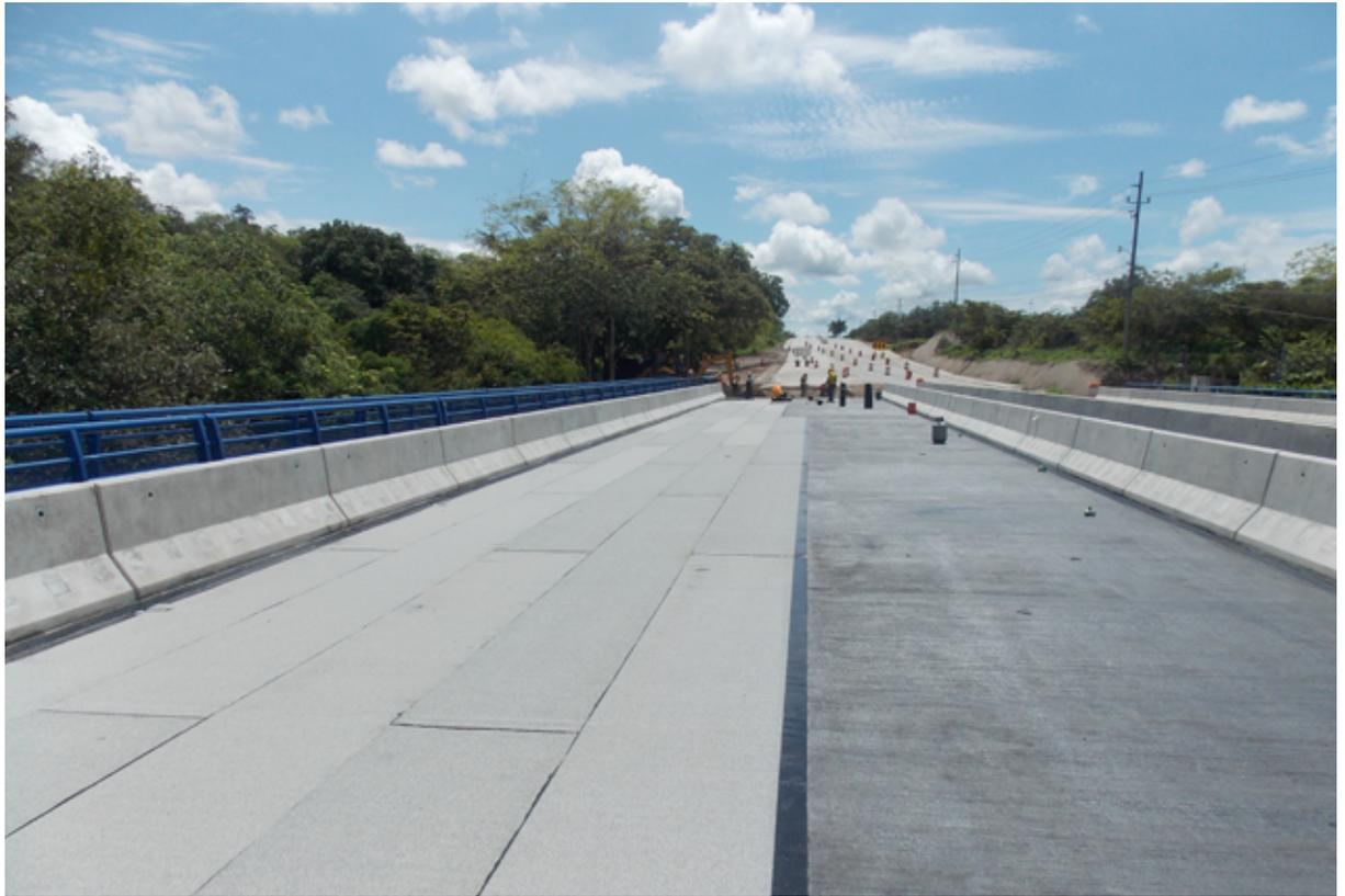
Colocación de membrana impermeable en el puente sobre el río Salto, Ruta Nacional No. 1 (Vargas-Alas, 2015)
