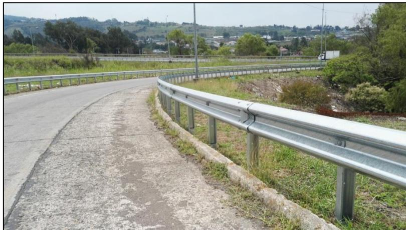
Figura 12.9. Sistema de contención colocado en la Florencio del Castillo
